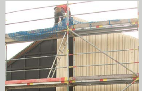
Montage der vorgefertigten Fassaden-Elemente
