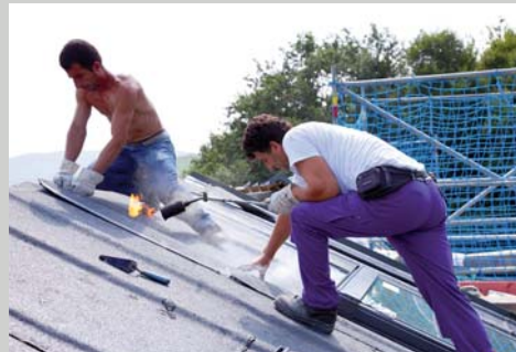
Flämmen der Decklage
