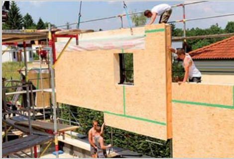
Aufrichten des Hauses
