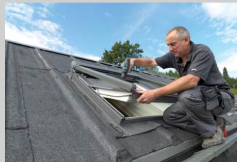
Montage des Sonnenschutzes
