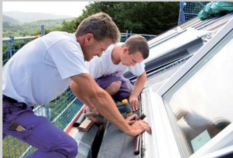
Anpassen der Eindeckrahmen durch Spengler
