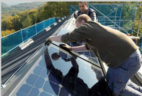
Montage der PV-Elemente
