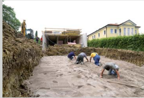
Herstellung des Erdkollektors
