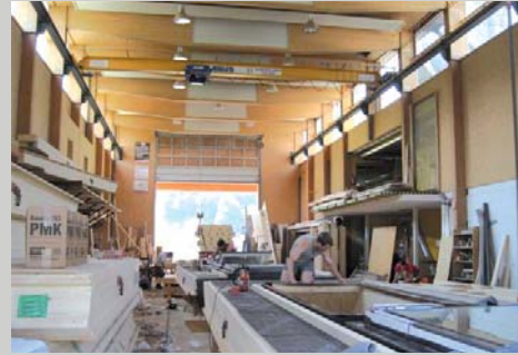
Vorfertigung der Holzelemente
