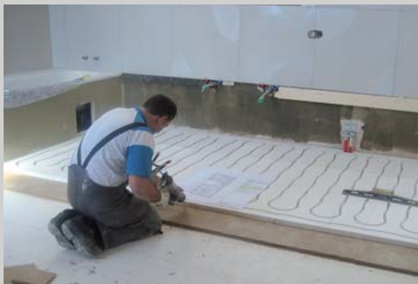
Trockenestrich vorbereitet für Fußbodenheizung
