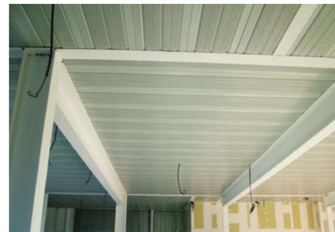
Soffit of Cofradal® Decibel
