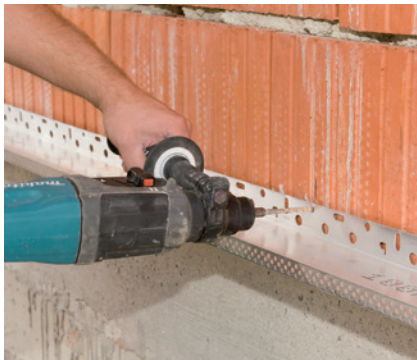
Sockelprofil in Plattendicke mit Dübel befestigen und z.B. mit Baunit KantenFix verkleben.
