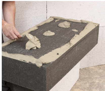
Kleber auf Austrotherm EPS® F-PLUS Platte im Randwulst-Punkt-Verfahren auftragen.
