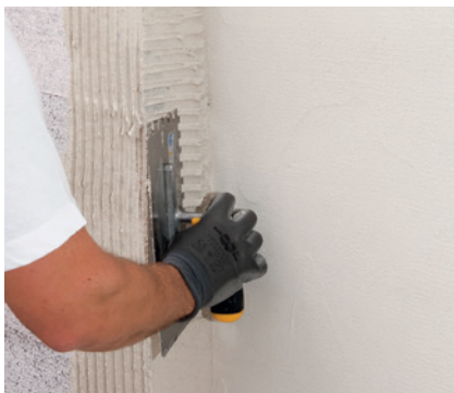
Nach Überschleifen der Platten: Kleber auftragen und Textilglasgitter einbetten (Überlappung mindestens 10 cm).
