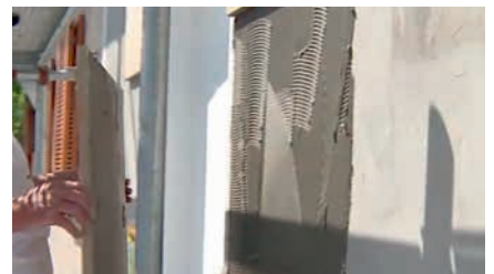
Auch der Untergrund wird vollflächig mit normgerechtem Fassadenkleber versehen.
