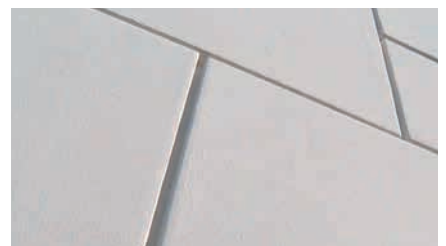
Danach kann die entsprechende Oberflächenfarbe im Rollverfahren dünnsschichtig aufgetragen werden.
