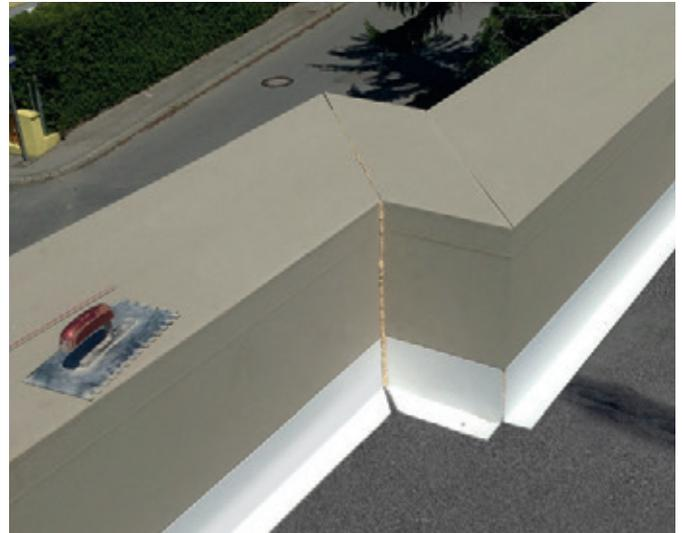
Das Austrotherm Attikaelement ist die neue kostengünstige Alternative zur herkömmlichen Attika Bauweise. Wo bisher teure Betonschalungen und zusätzliche Dämmelemente notwendig waren, kann nun das neue Fertigteilelement eingesetzt und dadurch kräftig gespart werden.
