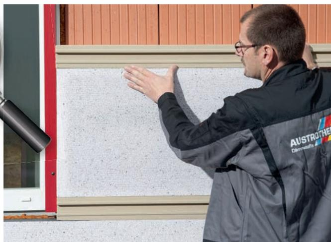
Die Austrotherm Nutprofile sind robust, biegsam und leicht verarbeitbar. Durch die Beschichtungsmasse und den Endanstrich ist das Nutprofil zudem nicht nur 100 % witterungsbeständig, die Beschichtung kann auch mit jeder gewünschten Fassadenfarbe gestrichen werden.
