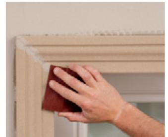
**Farben:** Nachdem alle Stöße nachbearbeitet wurden, kann Farbe aufgetragen werden. Die Fassadenfarbe auf Silikat-, Kunstharz-, bzw. Silikonbasis wird im Streich-, Roll- oder Spritzverfahren dünn-schichtig auf den staubfreien und trockenen Profilen aufgebracht.
