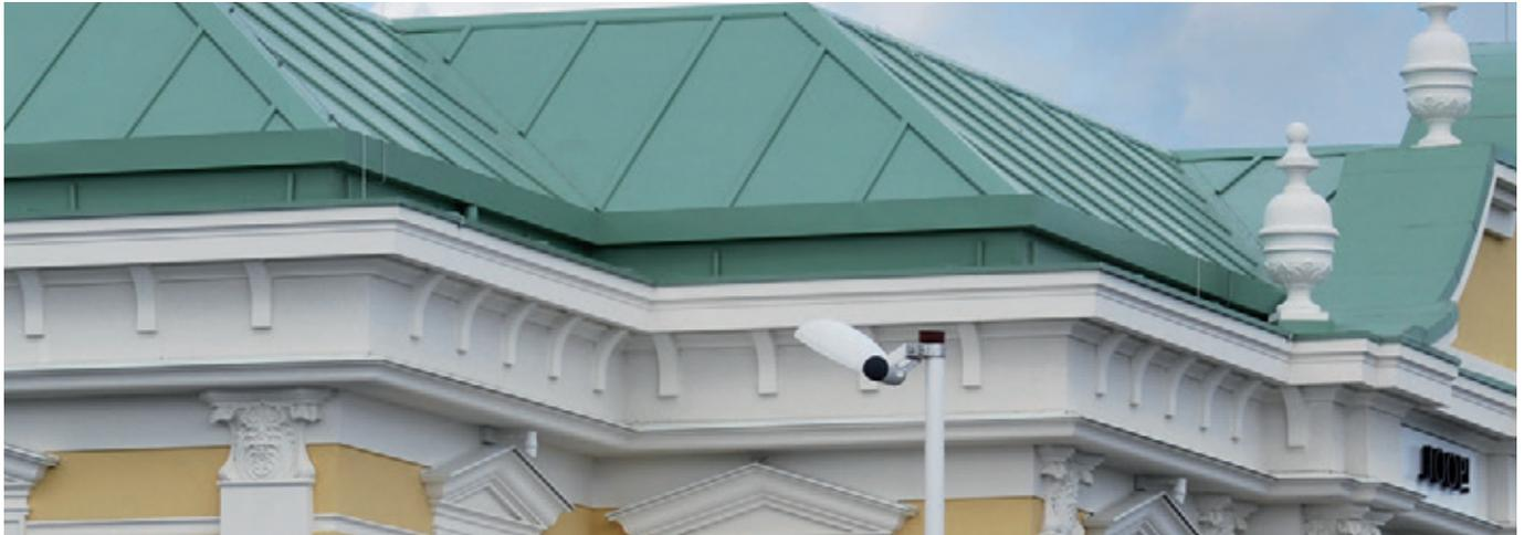
Als dekoratives Gestaltungselement zwischen Dach und Fassade können Gesimse von Austrotherm® verwendet werden. Austrotherm® liefert aber auch jeden gewünschten Querschnitt von Gesimsen.
