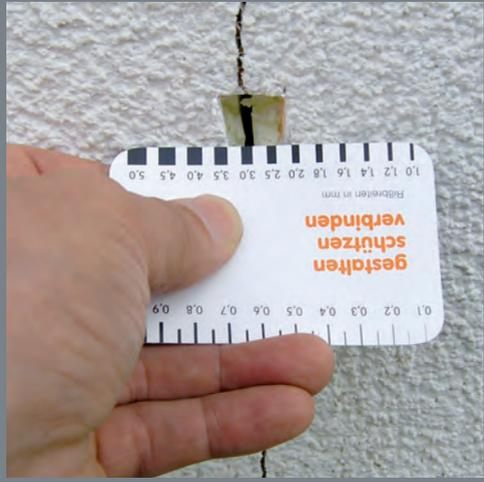
Bei der traditionellen Detailausführung sind teilweise Risse zu beobachten. Erkennbar ist diese Art von Schäden an ihrer Lage direkt über den Plattenstößen, den regelmäßigen Abständen sowie deren senkrechten Verlauf.
