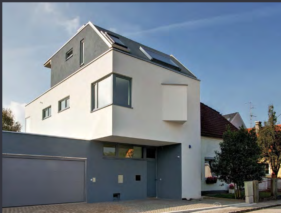
Einfamilienhaus Salzburg Anbau Energiekennzahl 15 kWh/m 2 a
