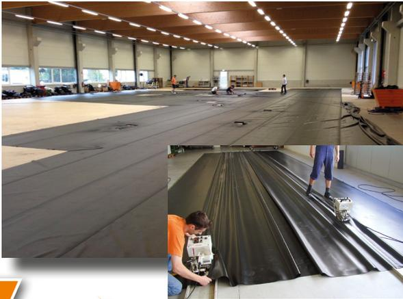
Auf Basis dieses Datenmaterials werden die Einzelteile der EPDM-Kautschukplane aus Bahnenmaterial zugeschnitten und mittels der **Thermofast® Fügetechnik dauerhaft dicht miteinander verschweißt** – alle Durchbrüche und Anschlüsse sind optimal vorbereitet.
