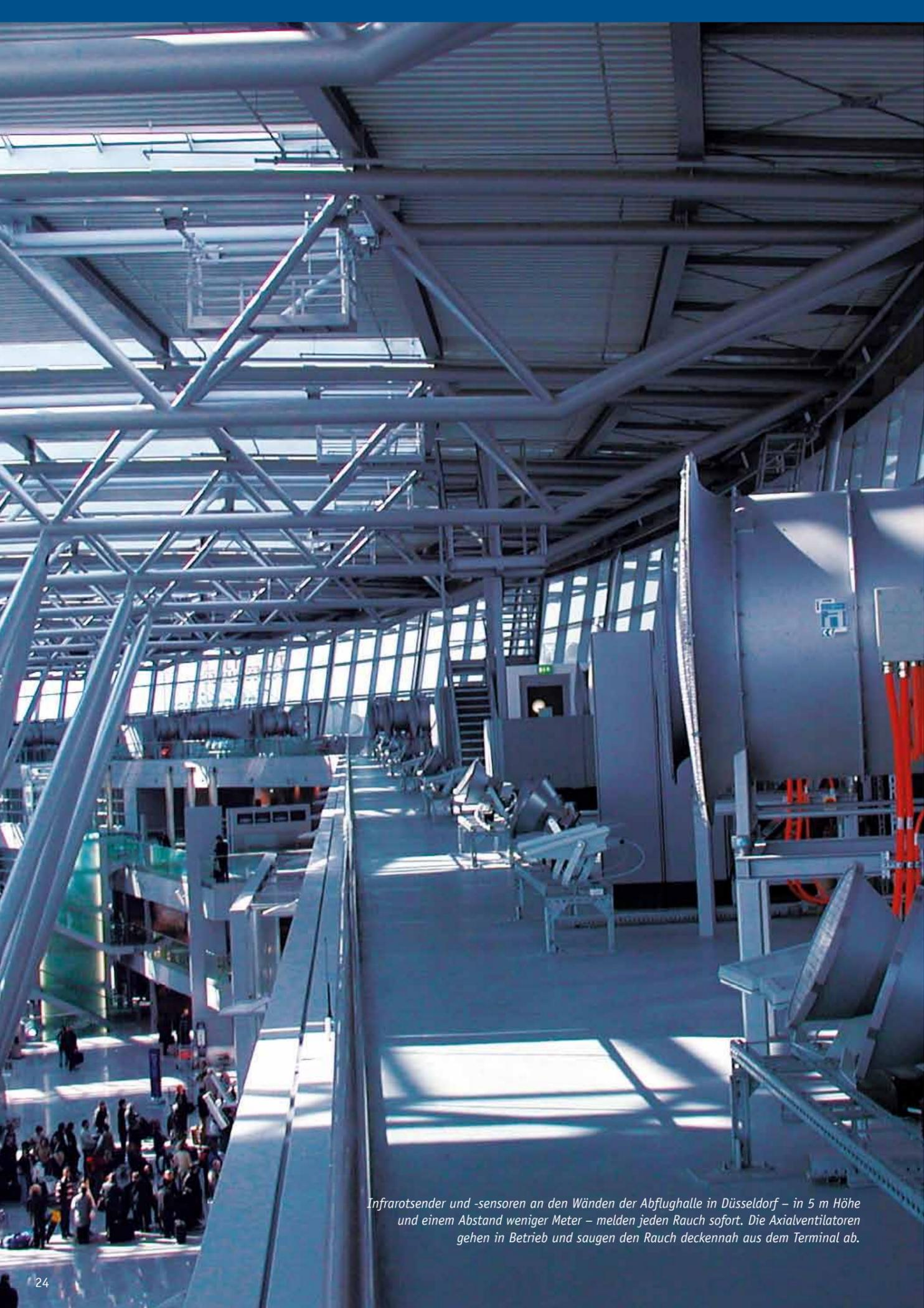
Infrarotsender und -sensoren an den Wänden der Abflughalle in Düsseldorf – in 5 m Höhe und einem Abstand weniger Meter – melden jeden Rauch sofort. Die Axialventilatoren gehen in Betrieb und saugen den Rauch deckennah aus dem Terminal ab.
