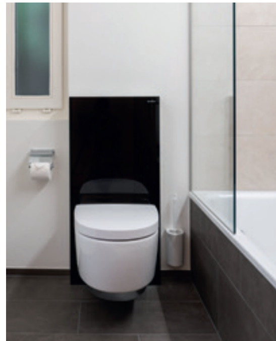
NACHHER Einbausituation mit Geberit Monolith
