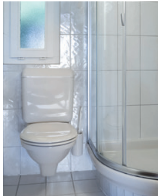
VORHER Einbausituation mit Aufputzspülkasten
