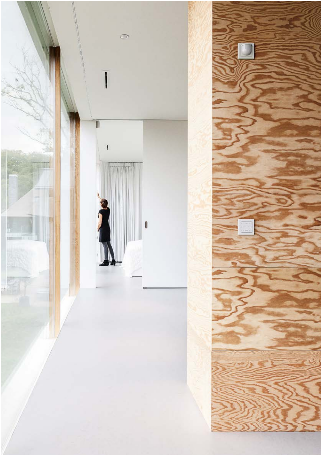
Abb.: Gira Bewegungsmelder und Gira Präsenzmelder sind auch für seltener genutzte Räume oder für Durchgangsbereiche praktisch. Damit wird das Licht eingeschaltet, sobald es benötigt wird. Gut zu wissen ist auch, dass es automatisch ausgeschaltet wird, wenn keine Person mehr anwesend ist.
