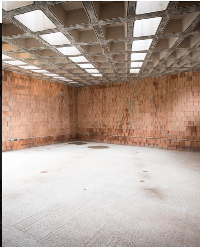
Realisierte Materialeinsparung und nachhaltiges Bauen – die BauMinator Betondrucktechnik schöpft dieses Potenzial maximal aus. Durch gezielte statische Konzepte wird an jeder Stelle nur so viel Material, wie unbedingt erforderlich eingesetzt – dadurch kann mehr als die Hälfte an Werkstoff eingespart werden. Aber nicht nur der ökonomische Aspekt spricht für eine Betondruckdecke – auch optisch können dadurch neue Wege beschritten werden. Neben den
