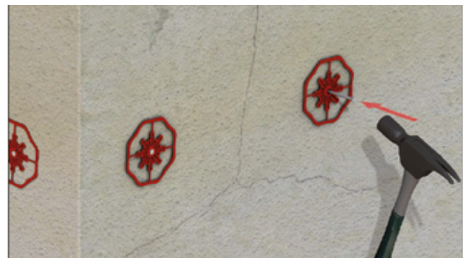
Abb. 1: Setzen der Baunit KlebeAnker mittels Hammer
