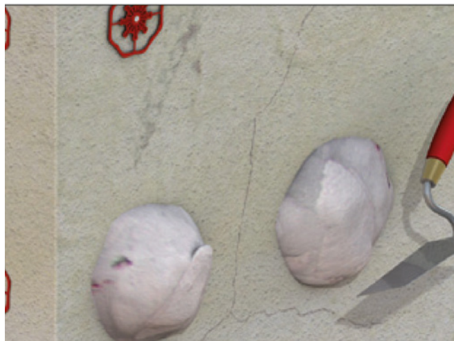
Abb. 7: Anwerfen der Kleberpatzen
