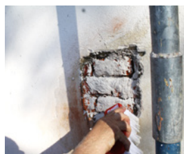
Vorspritzen auf vorgelassenen Untergrund mit Baumit MultiWhite
