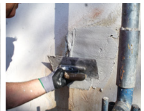
Ausputzen der Fehlstellen mit Baumit MultiWhite
