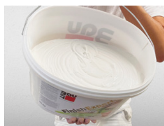
Abb. 2: Kübel über der Maschinenöffnung kippen.
