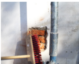
Putzfehlstellen reinigen
