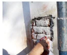
Vorspritzen auf vorgemässen Untergrund mit Baumit MultiWhite
