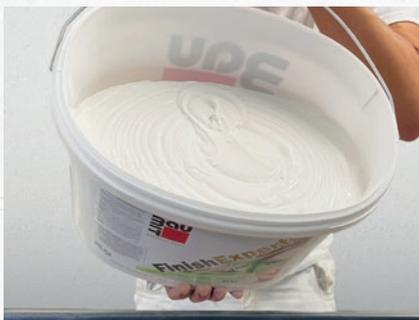
Abb. 2: Kübel über der Maschinenöffnung kippen.
