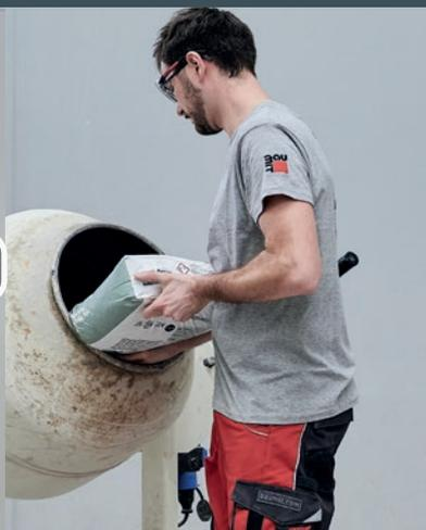
Der ALL IN TrockenBeton 20 überzeugt im neuen selbstauflösenden Sack. Im Vergleich zur herkömmlichen Herstellung eines Betons kommt es zu weniger Staubbildung und keinem Abfall auf der Baustelle.
