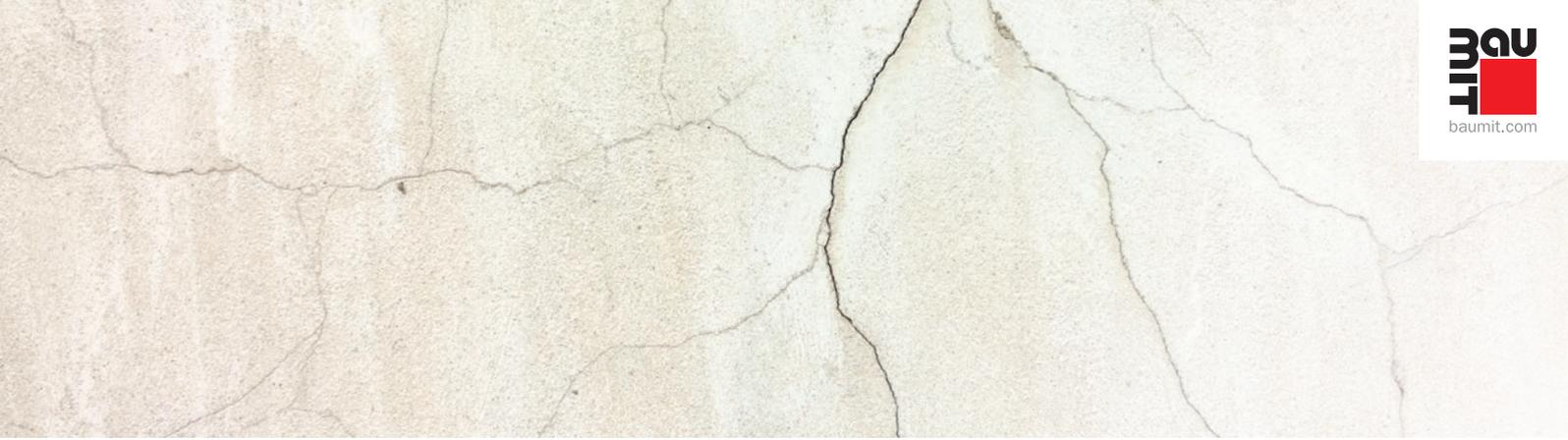
Wenn sich an der Fassade neben den üblichen Alterungserscheinungen bereits Risse bemerkbar machen, sollte schnell gehandelt werden, um mögliche Folgeschäden zu verhindern. Denn je größer der Riss, desto mehr Wasser kann eindringen und die Bausubstanz nachhaltig schädigen. Hier benötigt die Fassade eine eingehendere Behandlung, um seine technische und optische Funktion wieder voll zu erfüllen.
