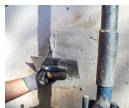
Ausputzen der Fehlstellen mit Baumit MultiWhite
