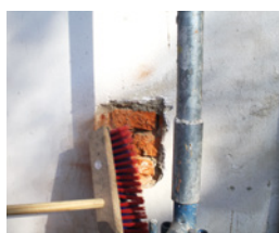
Putzfehlstellen reinigen
