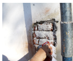
Vorspritzen auf vorgemässen Untergrund mit Baumit MultiWhite
