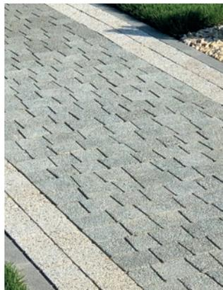
In der gebundenen Bauweise werden Bettung und Fugenfüllung unter Zusatz von Bindemitteln hergestellt. Pflastersteine werden in eine Bettung aus Mörtel gepflastert. Bei der Planung sind thermische Beanspruchungen durch große Temperaturunterschiede und die Orientierung der Fläche nach den Himmelsrichtungen zu beachten.
