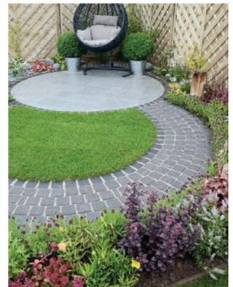
Bei der gemischten Bauweise werden die Bettung ungebunden und die Fugenfüllung unter Zusatz von Bindemitteln hergestellt. Die gemischte Bauweise sollte nur für begangene oder gering befahrene Flächen mit PKW-Verkehr gewählt werden, da die Belastbarkeit geringer ist als bei den anderen Bauweisen. Thermische Beanspruchungen sind zu beachten. Temperaturverursachte Risse in den Fugen sind unvermeidbar.
