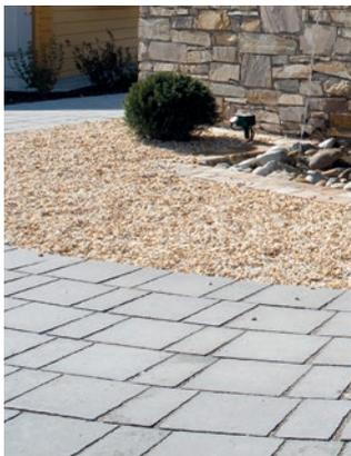
Bei der ungebundenen Bauweise werden Bettung und Fugenfüllung ohne Zusatz von Bindemitteln hergestellt. Es entsteht ein in sich stabiles Tragwerk, das Einzellasten flächig ableitet. Ungebundene Pflasterflächen verhalten sich flexibel: bei Belastung können Verformungen entstehen, die bei Entlastung teilweise wieder zurückgehen können. Unter Umständen entstehen Spurrinnen.
