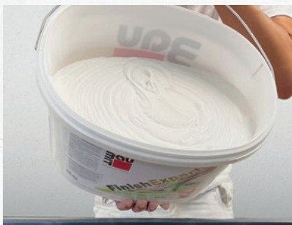
Abb. 2: Kübel über der Maschinenöffnung kippen.
