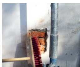
Putzfehlstellen reinigen
