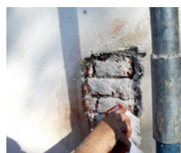
Vorspritzen auf vorgemässen Untergrund mit Baumit MultiWhite
