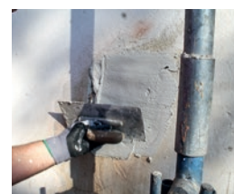
Ausputzen der Fehlstellen mit Baumit MultiWhite
