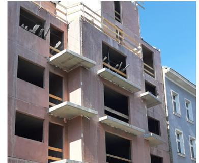
In der Mengergasse 60 in 1220 Wien wurde 2022 der Rohbau für ein siebengeschossiges Wohnhaus mit 27 Wohneinheiten als MABA Wohnbausystem errichtet. Rasche Montage und kurze Bauzeit sind nur einige Highlights des perfekt aufeinander abgestimmten Systems aus Fertigteilen.
