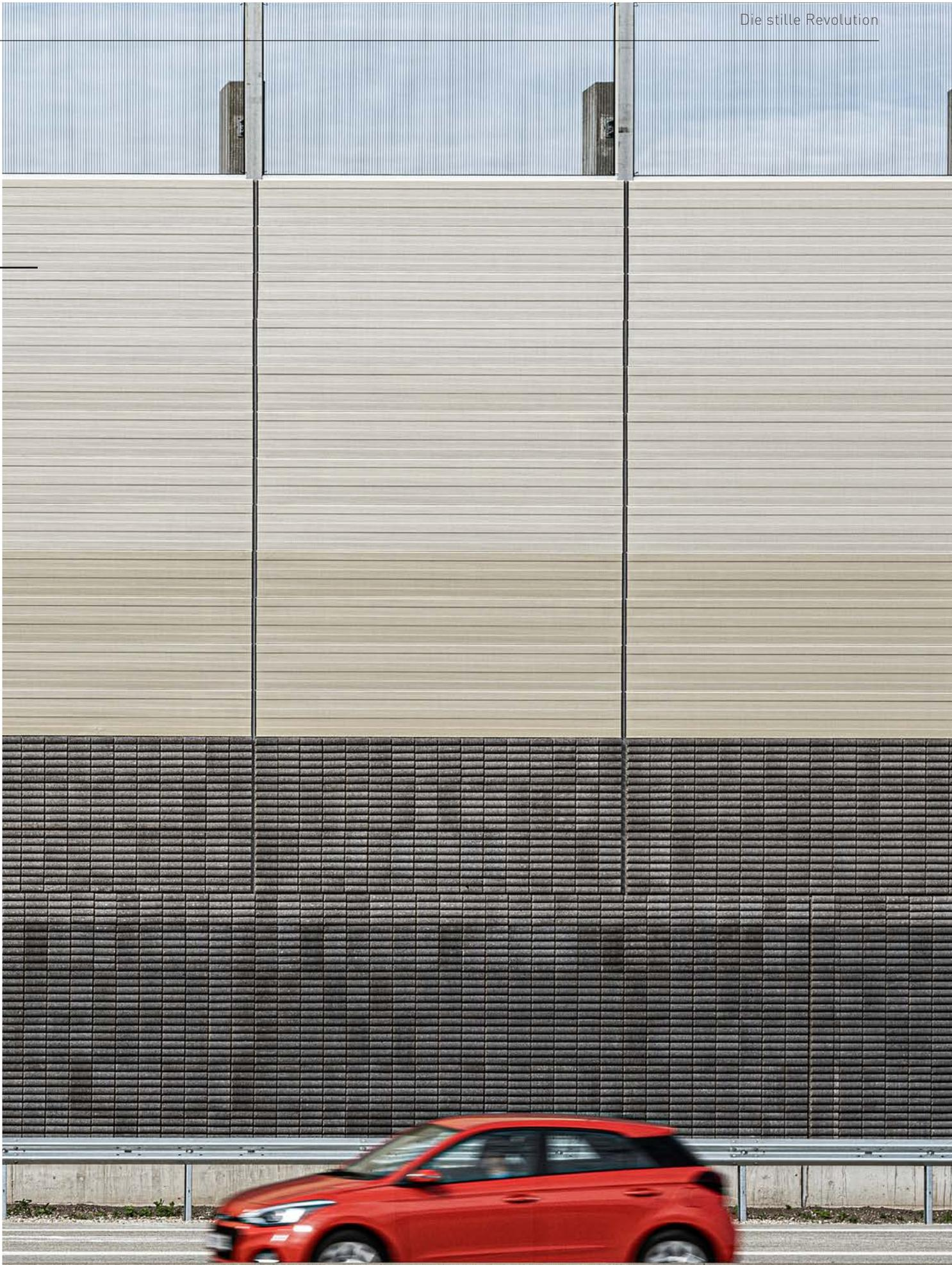
absorbieren sogar bis zu 20 dB an Schalldruck, womit sie je nach Oberflächengestaltung bis zur höchsten Absorptionsklasse A5 einsetzbar sind.
