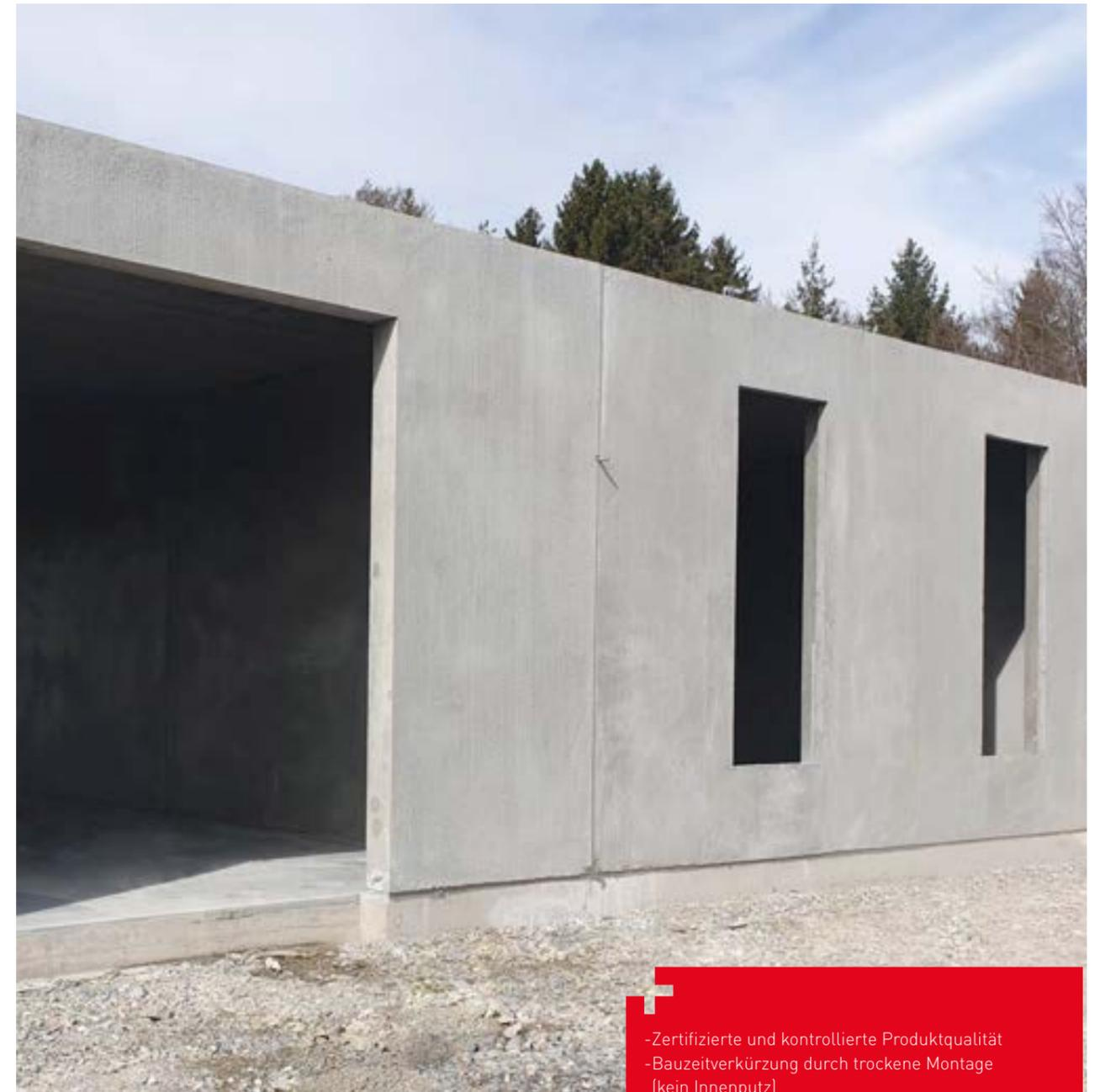
Vollwandplatten sind industriell vorgefertigte, großformatige und plattenförmige Vollfertigteile aus Normalbeton. Die geschoßhohen Wandelemente werden als tragende und/oder aussteifende Außen- und Innenwände in weiten Bereichen des Hochbaus eingesetzt.
