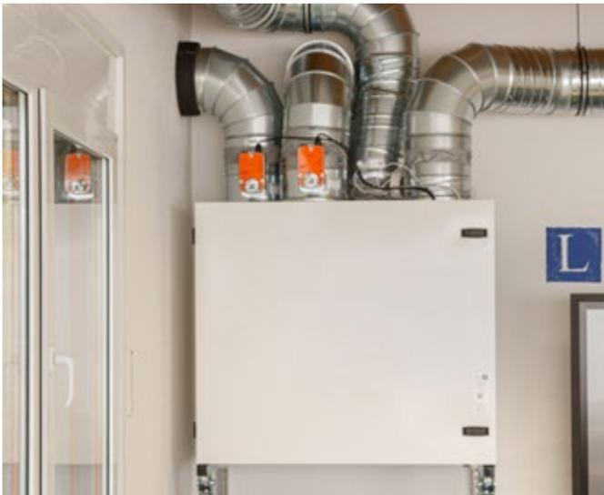
Installation des Centra-Lüftungsgerätes an der Wand im Klassenraum, inklusive Luftleitungen & Sensorik
