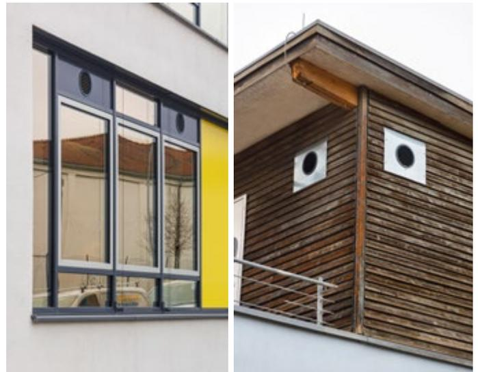
Fortuftauslässe und Außenlufteingänge befinden sich in den Oberlichtern der Fenster bzw. über Eck an der Außenwand
