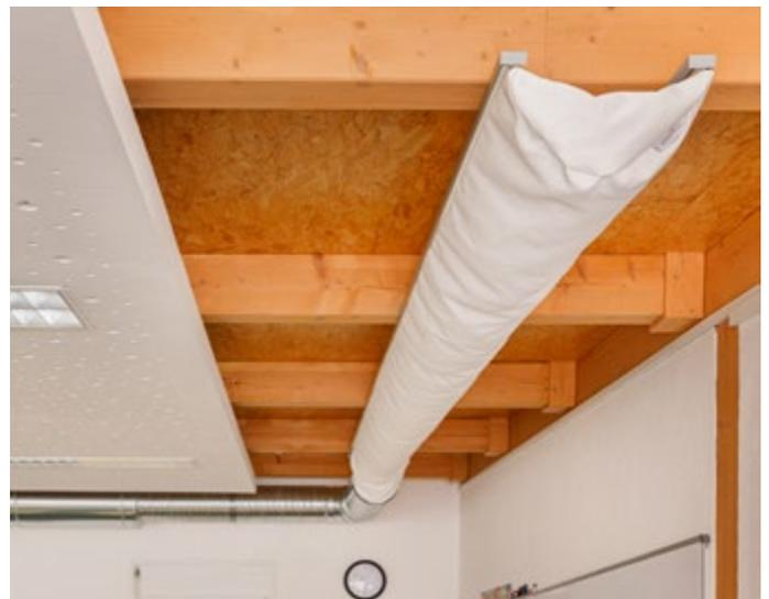
Zuluft strömt über einen Luftschlauch in den Raum
