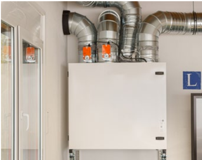
Installation des Centra-Lüftungsgerätes an der Wand im Klassenraum, inklusive Luftleitungen & Sensorik
