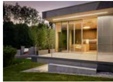
Einfamilienhaus Starnberger See, DE Ref. 780*
