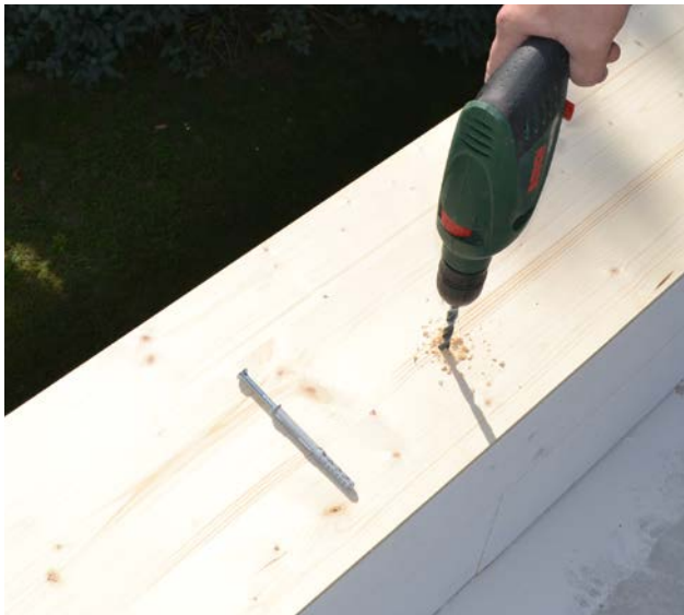
Die Unterlagsplatte mittels geeigneten Dübeln befestigen.
