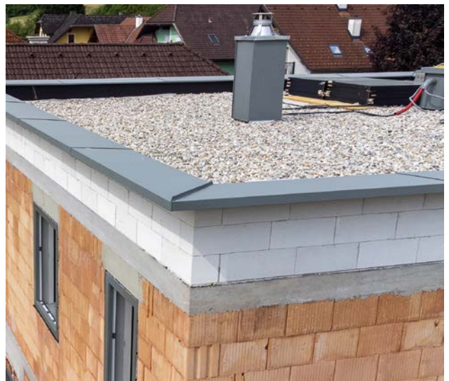
Durch die werkseitig hergestellte Neigung der abgeschrägten Attikasteine von 5° können Folgearbeiten für die Fertigstellung rasch und wirtschaftlich ausgeführt werden.
