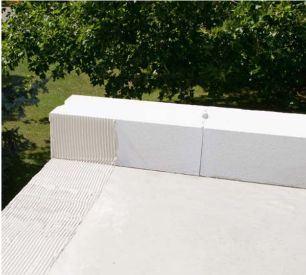
Ytong Steine in Dünnbettmörtel versetzen.
