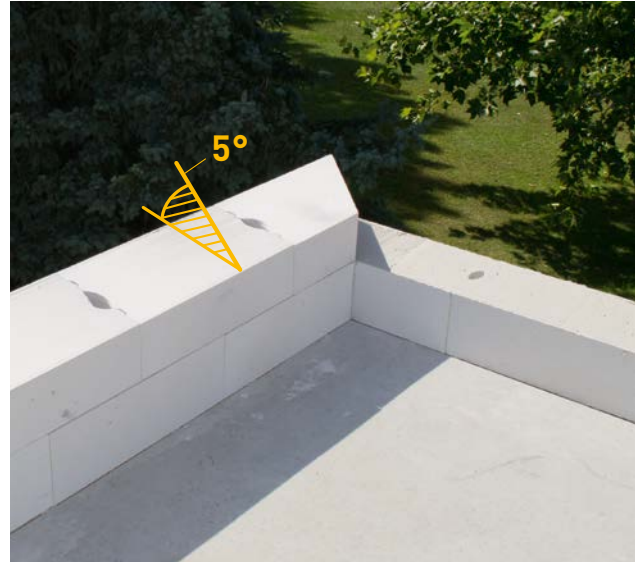
Abgeschrägte Ytong Steine aufsetzen und im Eckbereich auf Gehrung schneiden.
