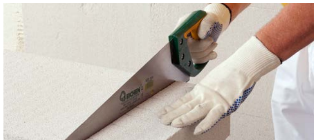
Schneiden Multipor Mineraldämmplatten
