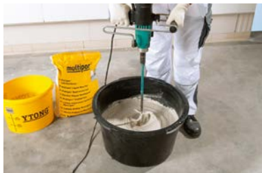
Anmischen Multipor Leichtmörtel
