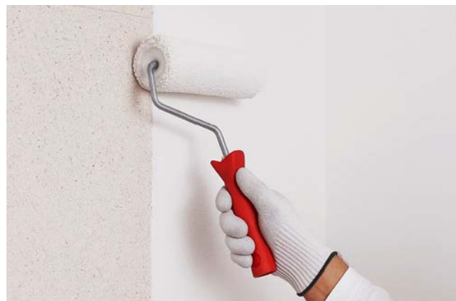
Streichen der Silikatfarbe
