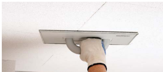
Beischleifen von Unebenheiten
