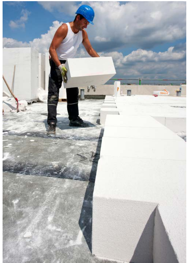
Multipor Mineraldämmplatte als Flachdachdämmung (mit und ohne Gefälle)
