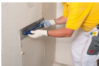
Aufziehen des Oberputzes
