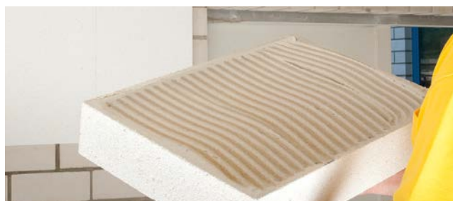
Mörtel vollflächig auf Mineraldämmplatte
