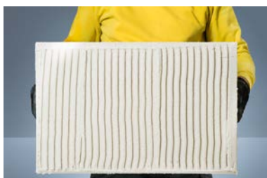
Mörtel vollflächig auf Mineraldämmplatte
