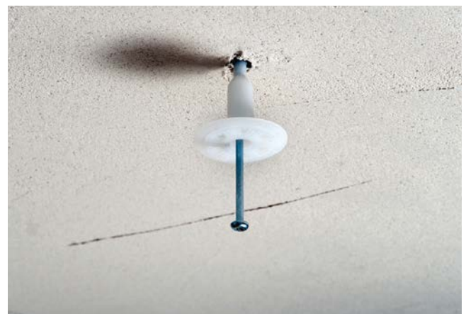
Setzen des Dübels „frisch in frisch“ durch das Gewebe
