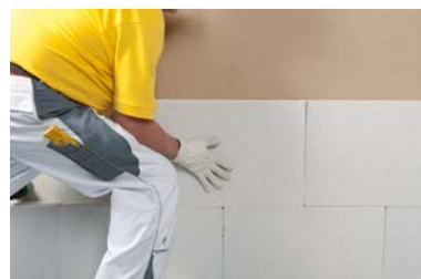
Stoß- und Lagerfuge dicht geschlossen im Verbund verlegen (mind. 15 cm Überbindemaß)
