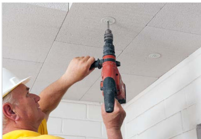
Setzen des Dübels (nach/bei Farbbeschichtung) oder wenn die Platten verspachtelt werden
