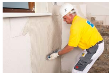
Aufziehen der Armierungsschicht
