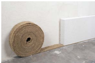
Entkopplungsstreifen setzen, z.B. Hanf
