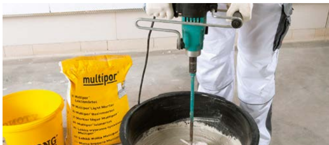
Anmischen Multipor Leichtmörtel
