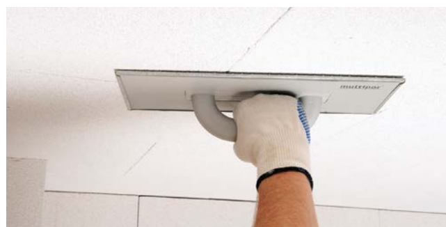
Beis Schleifen Multipor Dämmplatte
