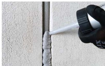
Aufbringen Aestuver Brandschutzmasse
