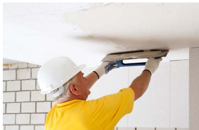
Aufziehen des Oberputzes
