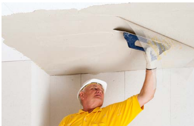
Aufbringen Armierungsschicht
