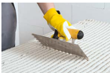
Leichtmörtel durchkämmen - 12er-Traufel bis 140 mm Dämmstoffdicke - 15er-Traufel ab 160 mm Dämmstoffdicke
