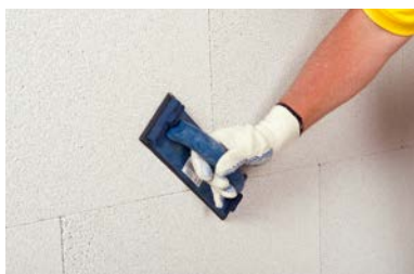
Beis Schleifen von Unebenheiten und Entfernung von Staub (Abkehren)
