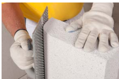
Anarbeiten von Rundungen
