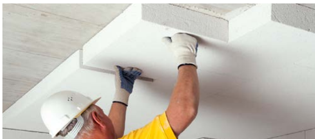
Ansetzen, andrücken und einschwimmen
