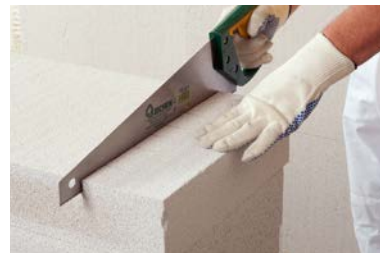
Schneiden Multipor Mineraldämmplatten
