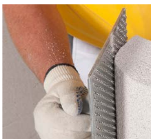
Anarbeiten von Rundungen
