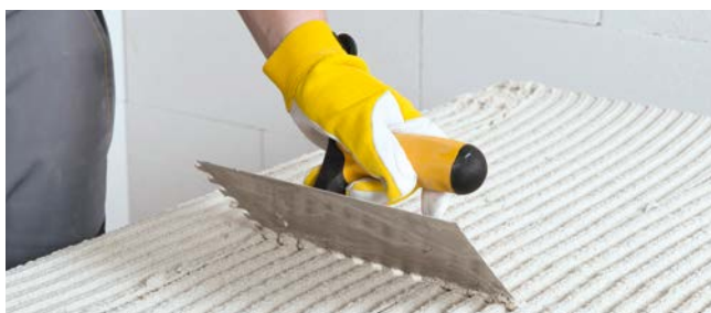
Leichtmörtel durchkämmen - 12er-Traufel bis 140 mm Dämmstoffdicke - 15er-Traufel ab 160 mm Dämmstoffdicke
