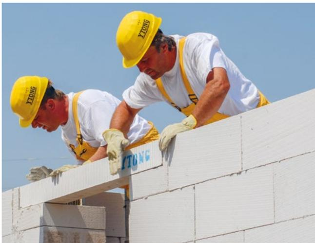
Erst nach Unterstellung darf mit der Übermauerung begonnen werden. Die Sturzunterstellung kann erst nach ausreichender Festigkeit der Druckzone entfernt werden.
