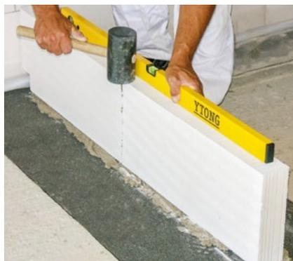
Das Ansetzen der ersten Schar gemäß Plan erfolgt nach Schnur oder Richtlatte. Die Steine werden mittels Wasserwaage und Gummihammer ausgerichtet. Die zweite Lage ist anschließend so zu mauern, dass die Ytong Verbundsteine im Verband gesetzt werden.
