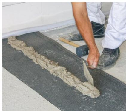
Das Ansetzen der ersten Schar erfolgt in einem Kalk-Zement-Mörtelband (Ausgleichsschicht). Analog zur ersten Schar bei Außenwänden ist hier ebenfalls über Fundamenten oder Kellerdecken eine Sperrschicht aus Bitumenbahn oder Dichtschlämme gegen aufsteigende Feuchtigkeit vorzusehen.
