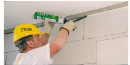
Die oberste Schar ist so einzupassen, dass eine etwa 10 mm hohe Fuge entsteht, die mit Montageschaum oder mit Dämmfilzstreifen inkl. Mörtel geschlossen wird.
