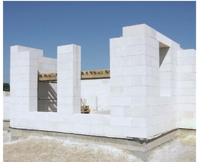
Ytong Verbundsteine weisen im Bereich der Stirnflächen eine Nut- und Federausbildung auf und werden daher knirsch (ohne stirnseitige Vermörtelung) gestoßen. Die Lagerfuge wird vollflächig vermörtelt.
