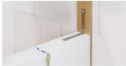
Hierzu ist der seitliche Anschluss mit Einlage eines Dämmstreifens (Unterlagsstreifen) auszuführen.
