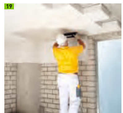
Multipor Leichtmörtel aufziehen ...
