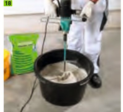
18 Multipor Leichtmörtel anmischen
