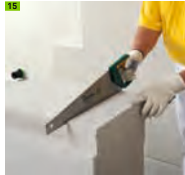
Schneiden von Passplatten
