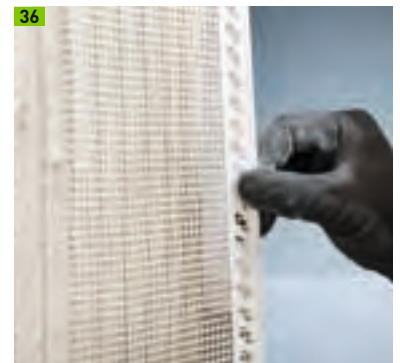
Gewebeeckprofil an Außenecke
