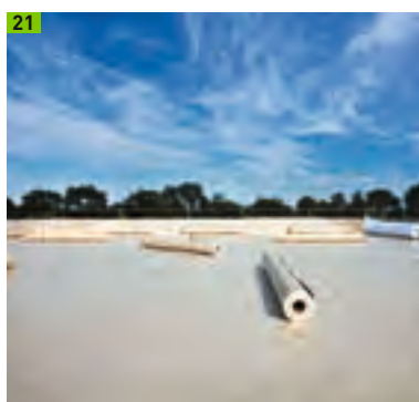
21 Kunststoffdichtungsbahn lose verlegt mit Auflast
