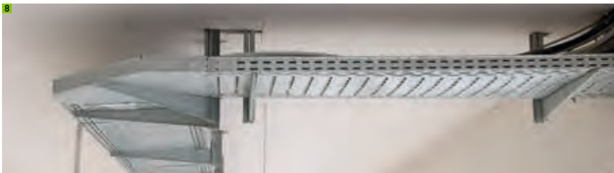
Befestigung eines Kabelträgers
