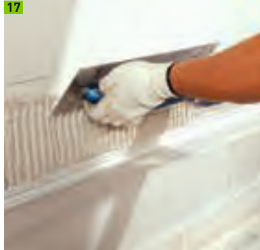
17 Sockelabschluss mit Gewebewinkel
