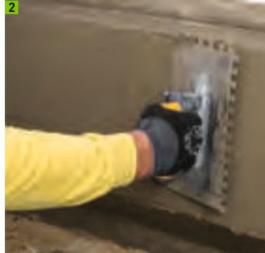
Abdichtung eines Sockels
