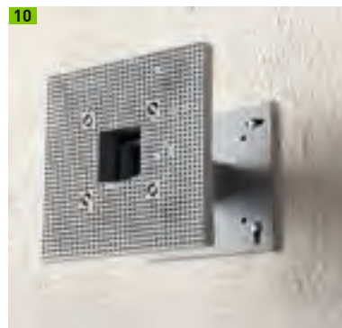
Einbau des Multipor Geräteträgers
