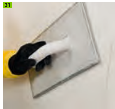
Beischleifen der Oberfläche
