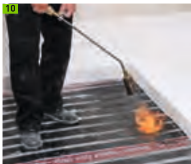
Dämmplattenverlegung auf oberseitig thermisch aktivierbare Dampfsperre
