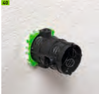
Steckdosenset, auf der Wand befestigt
