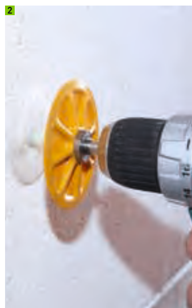
Setzen des Multipor Schraubdübels
