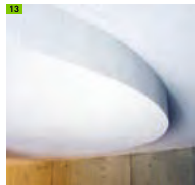
Platte an Rundes und Eckiges anpassen
