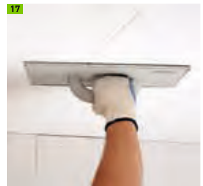
Einfaches Beischleifen
