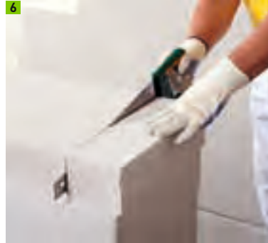
Zuschnitt der Multipor Steildachdämmung DAD
