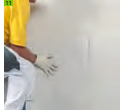
Stoß- und Lagerfuge dicht gestoßen
