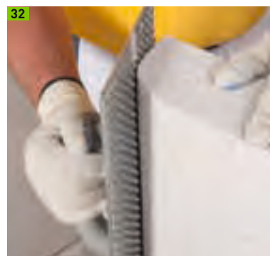
Anpassung der Dämmplatte
