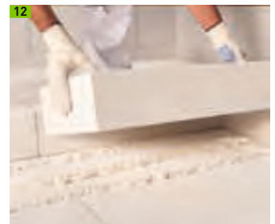
Dämmplattenverlegung in PU-Dämmstoffklebeschäum, hier als Montagefixierung
