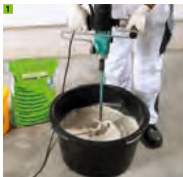
Multipor Lehmörtel anmischen
