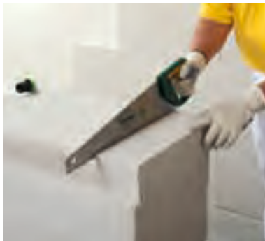
Schneiden von Passplatten
