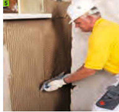
Armierungsschicht auftragen
