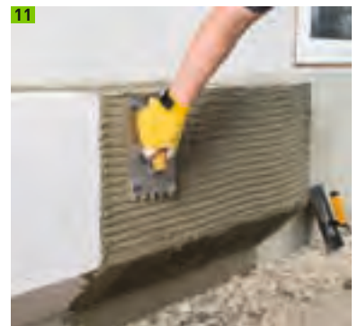
11 Für die Armierungsschicht Multipor Dichtschlämme auf die Multipor Sockeldämmplatte auftragen
