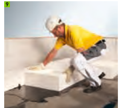
Dämmplattenverlegung in Heißbitumen
