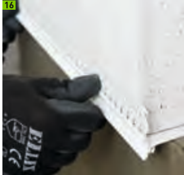
16 Sockelabschluss mit Gewebewinkel
