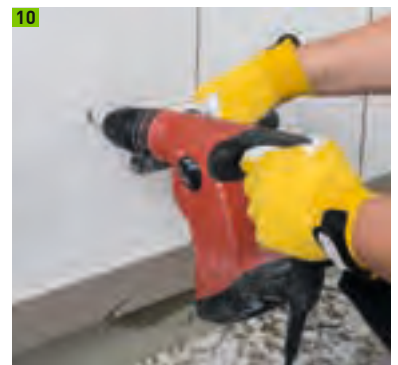
10 Multipor Schraubdübel setzen, Multipor Sockeldämmplatte fixieren und 24 Stunden trocknen lassen
