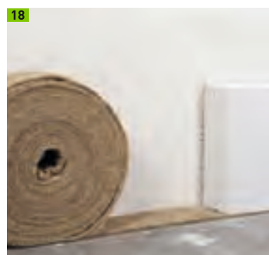
Elastische Entkopplung zum Fußboden
