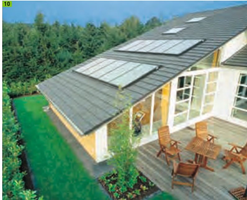
Fertige Dachausbildung mit integrierter Solaranlage
