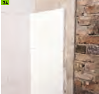
Einbindende Innenwand, mit Dämmkeil gedämmt
