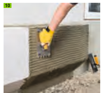
Sockelausführung mit Multipor Sockeldämmplatten
