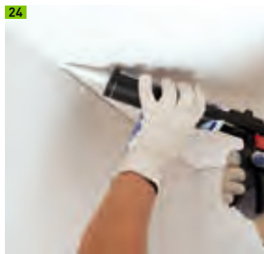
Anschluss zwischen Wand und Decke
