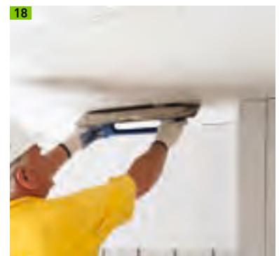
Multipor Leichtmörtel aufziehen
