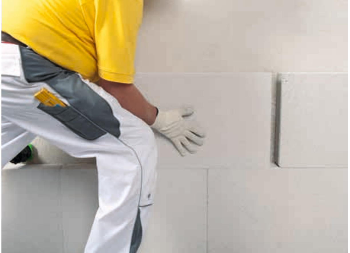
Abb. 6: Beispielhafter Wandaufbau mit Multipor Innendämmung
