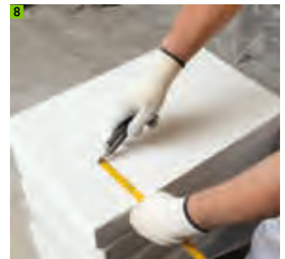
Platte ausklinken bei vorhandenen Leitungen
