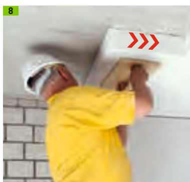
Quer zum Mörtelauftrag einschwimmen und andrücken
