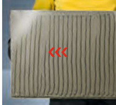
Stege verwischen beim Einschieben zu ...
