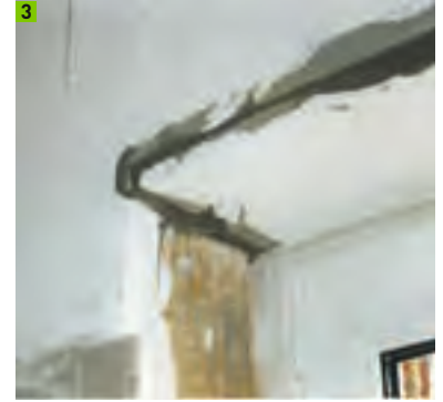
Innendämmung im Sturzbereich
