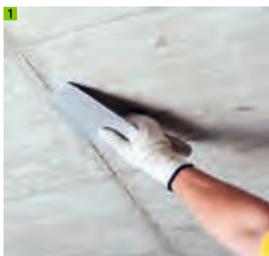
Überstehende Betongräte abstoßen ...
