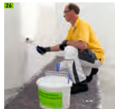
Auftragen der Multipor Innensilikatfarbe
