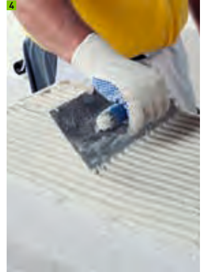
Leichtmörtel mit mind. 12er-Zahntraufel aufziehen
