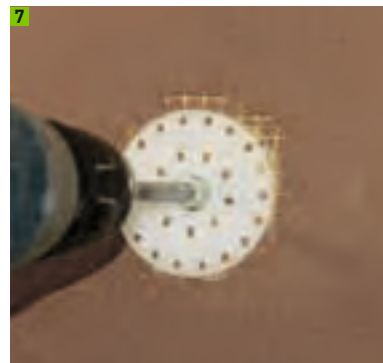
Setzen des Schraubdübels
