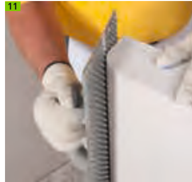
11 Platte an Rundes und Eckiges anpassen
