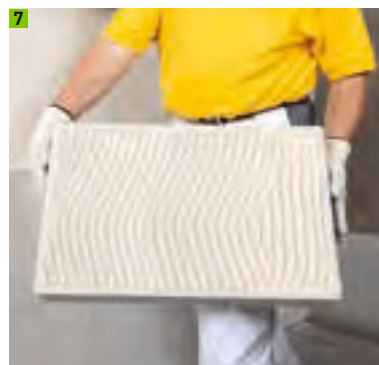
Mörtel vollflächig auf Mineraldämmplatte
