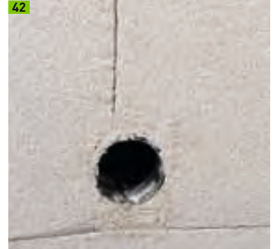
Multipor komplett angearbeitet
