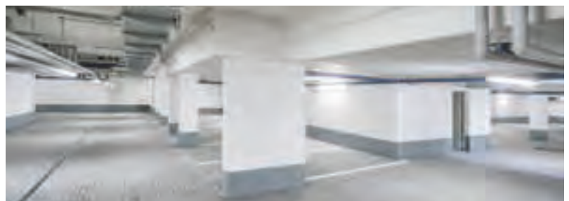
Kellerdecke und Tiefgaragendecke
