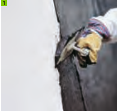
Isolierung einer Kellerwand
