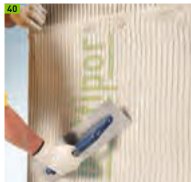
Armierungsgewebe einlegen
