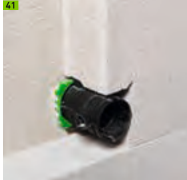
Anarbeitung der Dämmung
