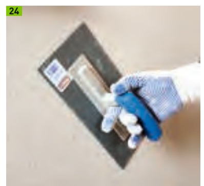
Strukturieren mittels Traufel
