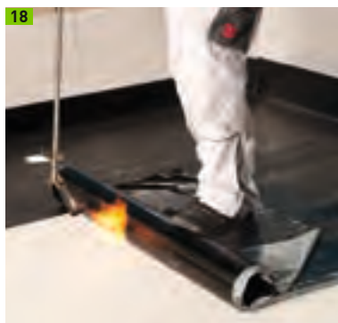
18 Erste Abdichtungslage als thermisch aktivierte Kaltselfstklebebahn
