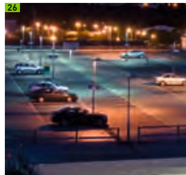
Parkdach mit Stahlbetonplatten
