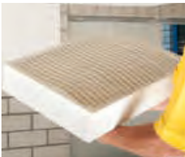
Einfache Klebmontage bei einer Bestandsdecke
