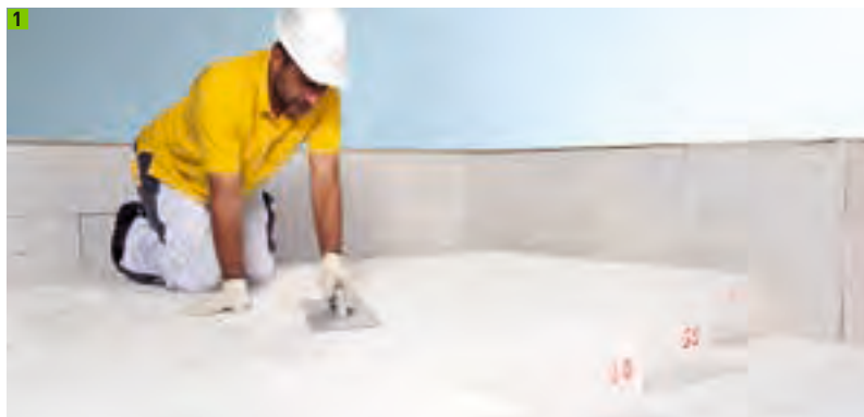
Gefälleplattenverlegung
