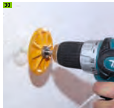
Setzen des Schraubdübels
