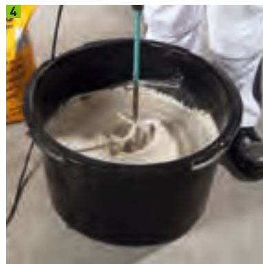
Anmischen von Multipor Leichtmörtel
