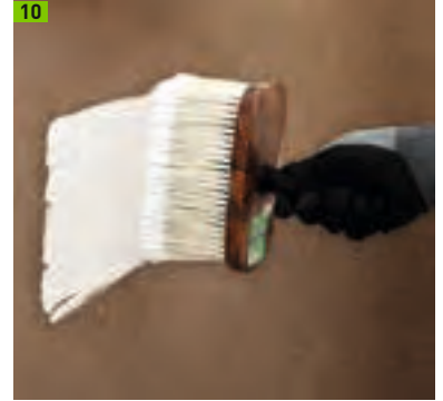
Farbauftrag mittels Rolle, Quast oder Pinsel
