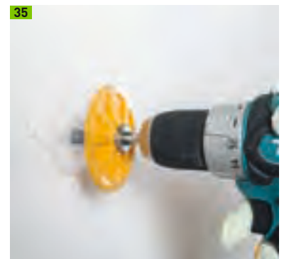
Schraubdübel setzen
