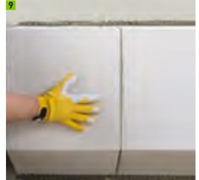
9 Multipor Sockeldämmplatte andrücken und einschwimmen
