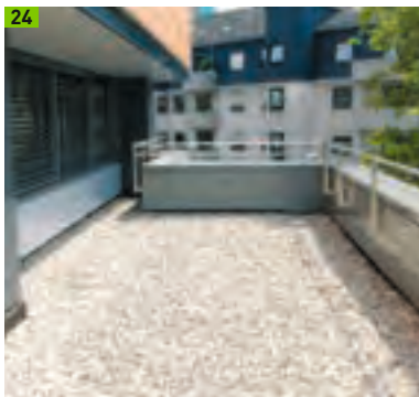
Dachfläche mit Kies 16/32
