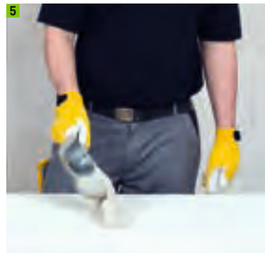
Auftrag des Leichtmörtels
