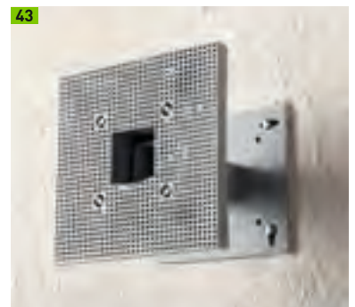
Multipor Teleskop Geräteträger an der Rohwand
