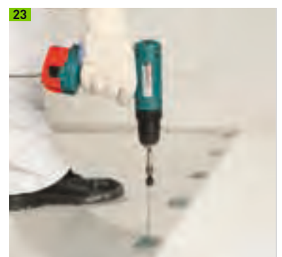
23 Kunststoffdachbahnen mechanisch befestigt
