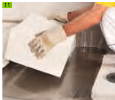
Dämmplattenverlegung in Flüssigdampfsperre
