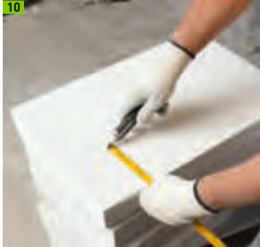
Platte vorbereiten zum Ausklinken
