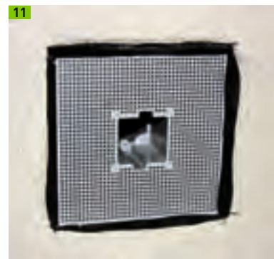
Eingebauter Multipor Geräteträger
