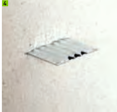
Einschlagen des Flachdübels
