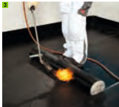
Dampfsperre mit Aluminiumeinlage als Schweißbahn
