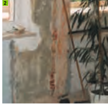
Untergrund vor der Sanierung
