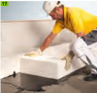
Dämmplattenverlegung in Heißbitumen
