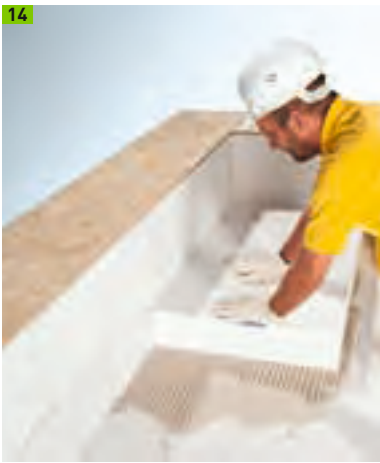
Dämmplattenverlegung in Multipor Leichtmörtel
