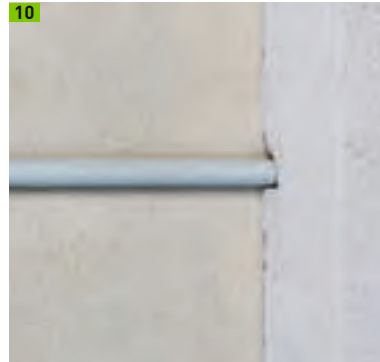
10 Platte ausklinken bei vorhandenen Elektroleitungen
