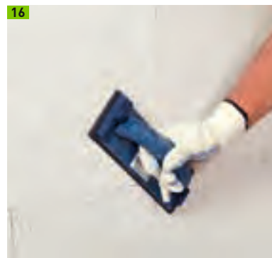
Beischleifen von Unebenheiten
