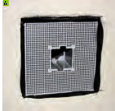
Eingebauter Multipor Geräteträger
