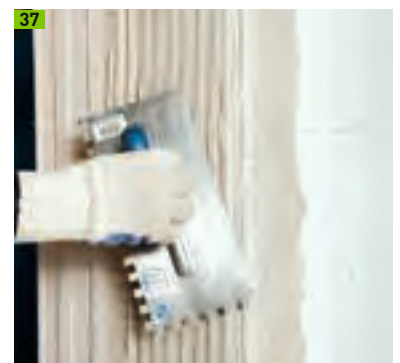
Gewebeeckprofil an Öffnung
