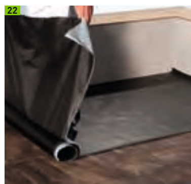
22 Kunststoffdachbahnen verklebt
