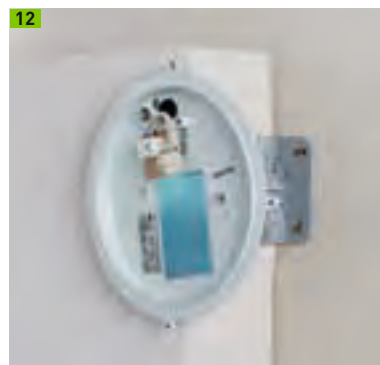
Multipor Geräteträger mit Leuchtenaufsatz
