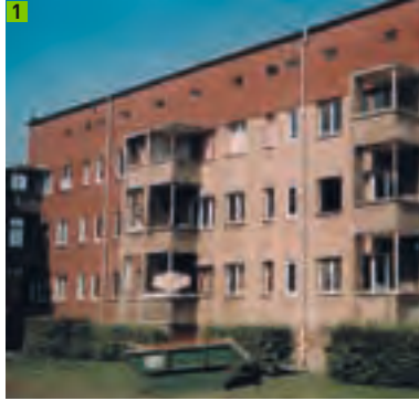
Außenansicht des Sanierungsobjekts in Finsterwalde, Friedensstraße
