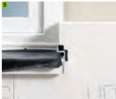
Bordprofil mit Fugendichtband
