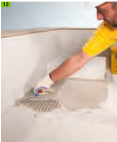
Multipor Leichtmörtel auftragen
