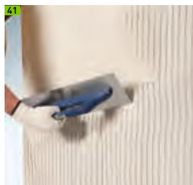
Armierungsgewebe einputzen
