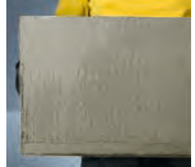
... einer vollflächigen Verklebung
