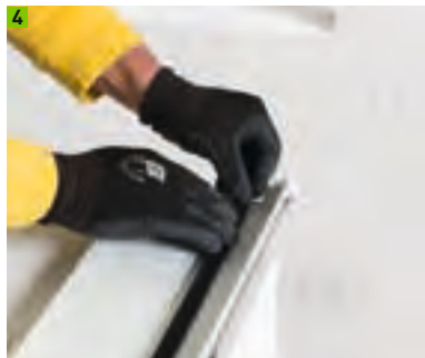
Anbringen des unterseitigen Dichtungsbandes
