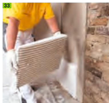
Einbau des Dämmkeils
