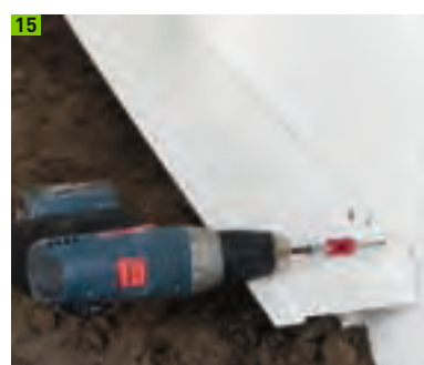
Sockelschiene, gedübelt
