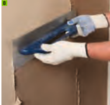
Aufziehen des Oberputzes
