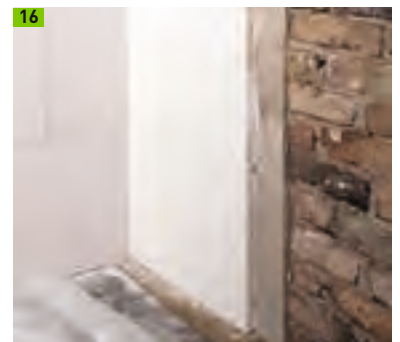
Einbindende Wand mit dem Multipor Dämmkeil
