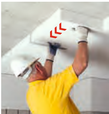
Verlegung Multipor Mineraldämmplatte DI
