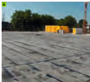
Dampfsperre mit Aluminiumeinlage, in Heißbitumen verlegt
