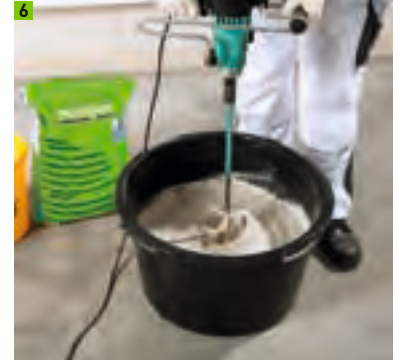
Multipor Leichtmörtel anmischen
