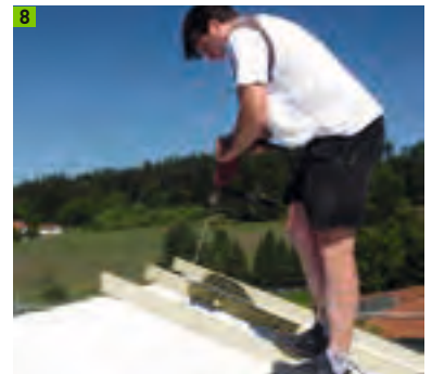
Einschrauben der Ytong Dachschraube auf dem Ytong Kombidach
