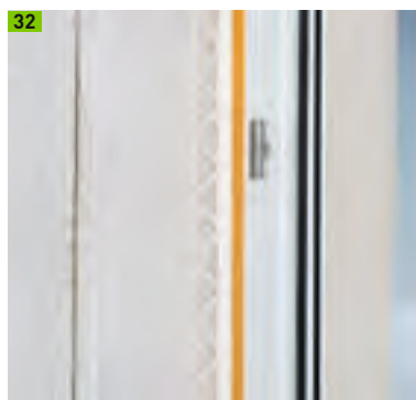
Setzen der Anputzleiste
