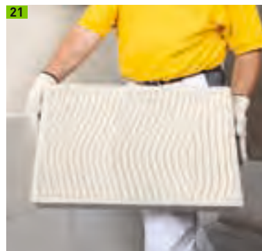
Multipor Leichtmörtel auf Dämmplatte aufgetragen
