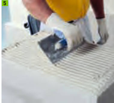
Vollflächiger Auftrag Multipor Leichtmörtel
