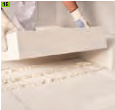
Dämmplattenverlegung mit PU-Kleber, hier als Montagefixierung
