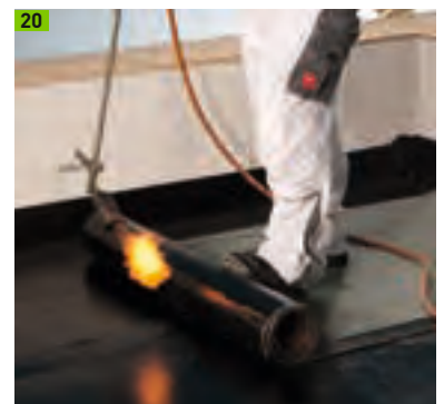
20 Zweite Abdichtungslage
