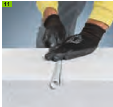
Platte ausklinken bei vorhandenen Leitungen
