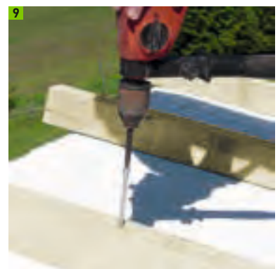
Vollständige Versenkung der Ytong Dachschraube in der Traglattung
