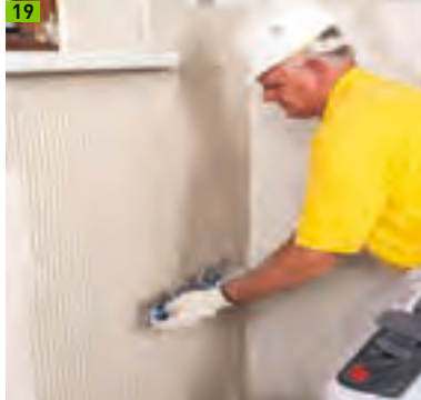
Aufziehen der Armierungsschicht
