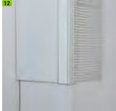
Seitlicher Putzabschluss
