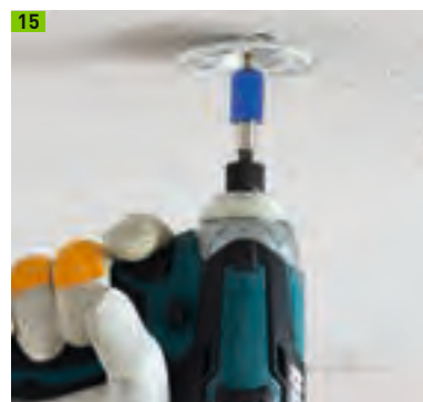
... Verdübeln mit Multipor Deckenbefestiger
