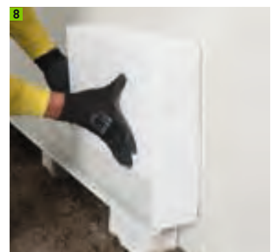
Einschieben der Mineraldämmplatte WAP
