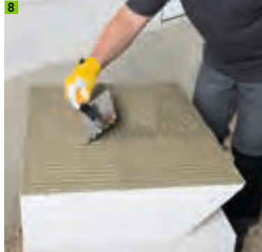
8 Multipor Dichtschlämme mit 12er-Zahntraufel vollflächig auftragen
