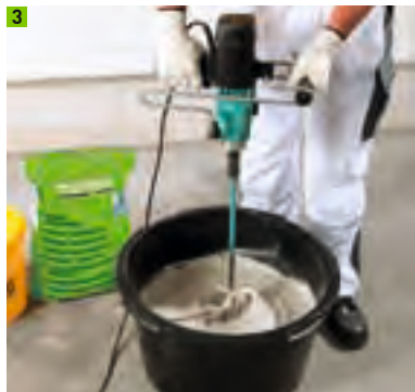
Anmischen Multipor Leichtmörtel
