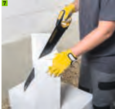
7 Multipor Sockeldämmplatte schräg zuschneiden
