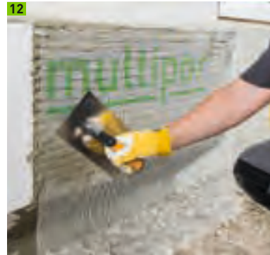
Multipor Armierungsgewebe auflegen und einputzen
