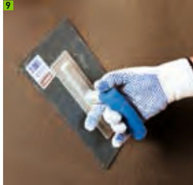
Strukturieren mittels Traufel
