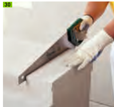
Schneiden der Mineraleddämmplatte
