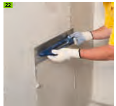
Aufziehen des Oberputzes
