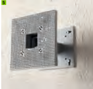
Einbau des Multipor Geräteträgers
