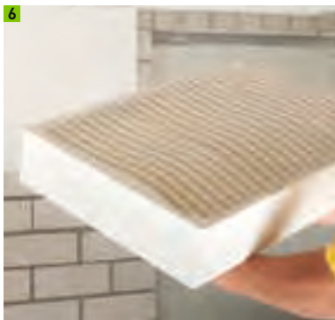
Ankleben der Mineraldämmplatte
