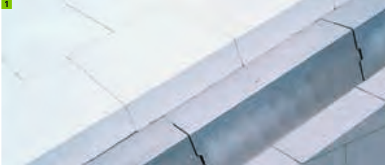
Multipor Mineraldämmplatte DAD auf gereinigter Fläche verklebt
