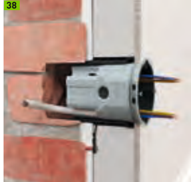
Eingebaute Multipor Innendämmungsdose
