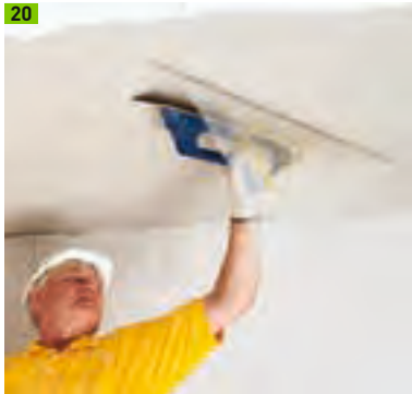
... und das Multipor Armierungsgewebe einbetten
