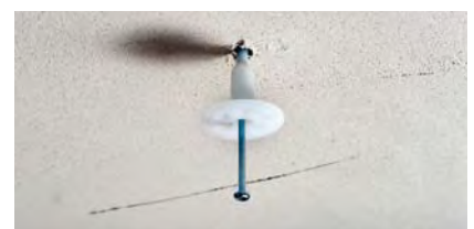
Setzen des Dübels „frisch in frisch“ durch das Gewebe
