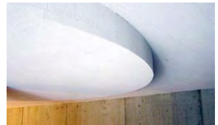
Anpassung an runde Anschlüsse
