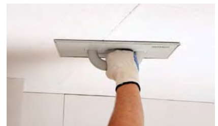
Beischleifen von Unebenheiten
