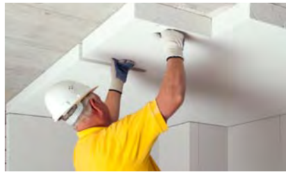
Ansetzen, Andrücken und Einschwimmen
