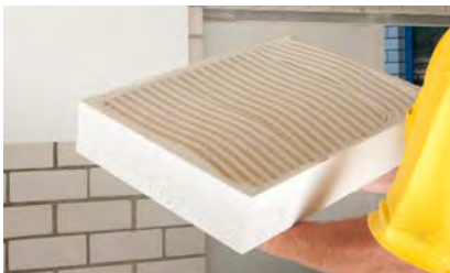
Mörtel vollflächig auf Mineraldämmplatte
