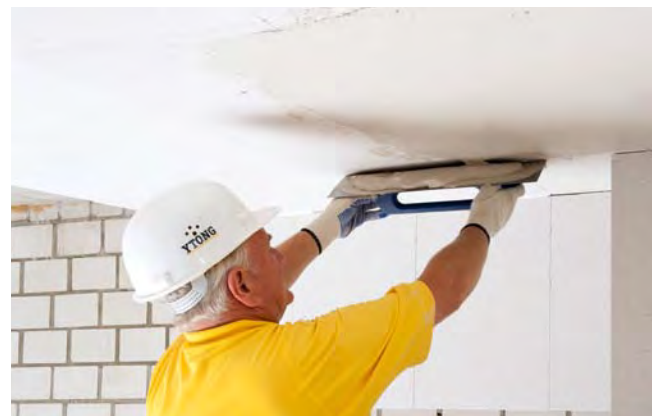
Aufziehen des Oberputzes
