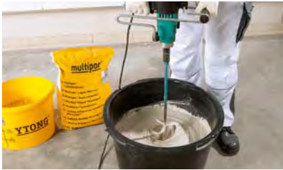
Anmischen Multipor Leichtmörtel
