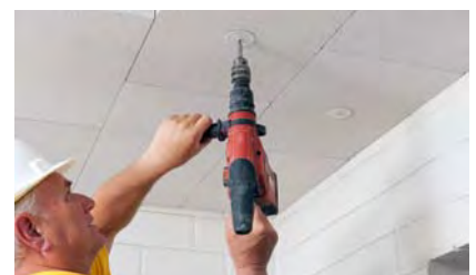
Setzen des Dübels
