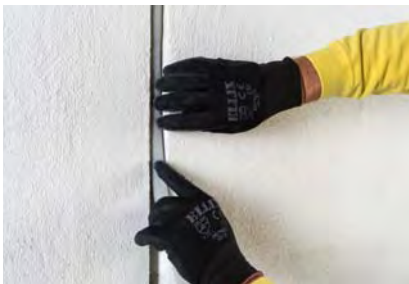
Einlegen der Aestuver Dehnfuge M
