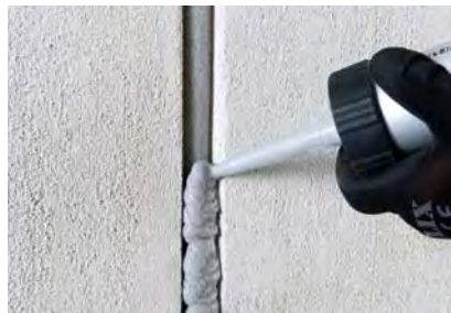
Aufbringen Aestuver Brandschutzmasse
