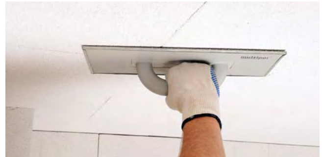
Beischleifen Multipor Dämmplatte
