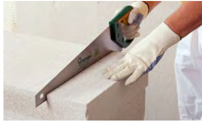
Schneiden Multipor Mineraldämmplatten
