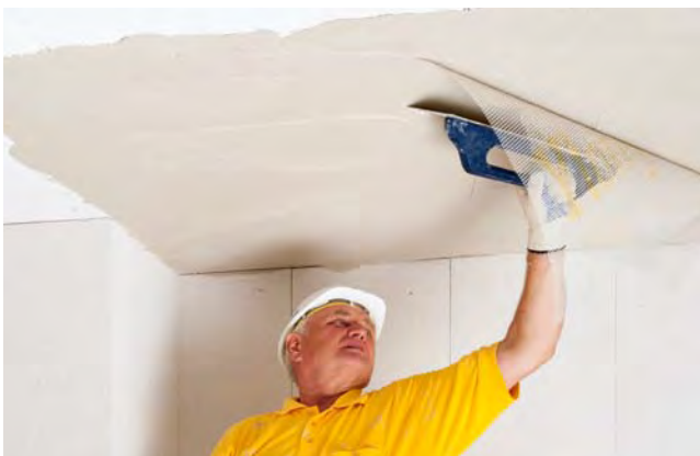
Aufbringen Armierungsschicht
