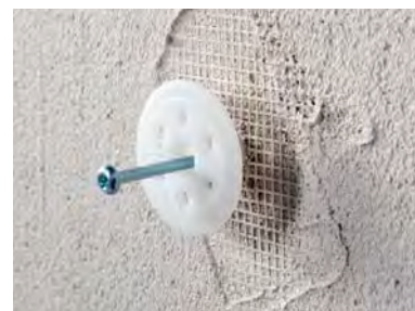
Setzen des Dübels durch das Gewebe
