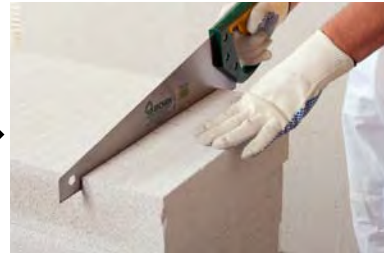
Schneiden Multipor Mineral- dämmplatten
