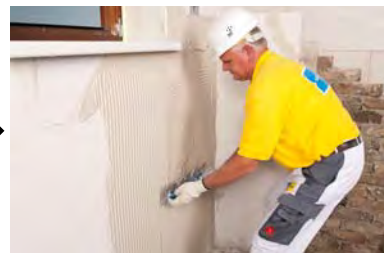
Aufziehen der Armierungsschicht
