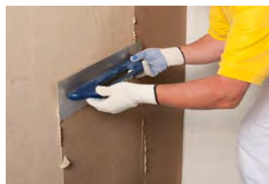
Aufziehen des Oberputzes
