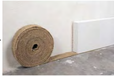
Entkopplungsstreifen setzen, z.B. Hanf
