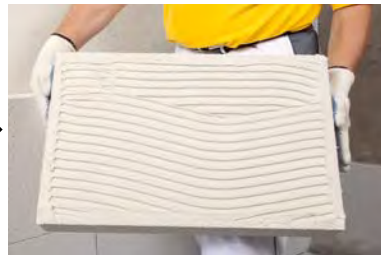
Mörtel vollflächig auf Mineral- dämmplatte
