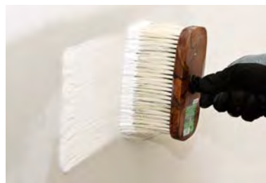
Streichen der Silikatfarbe
