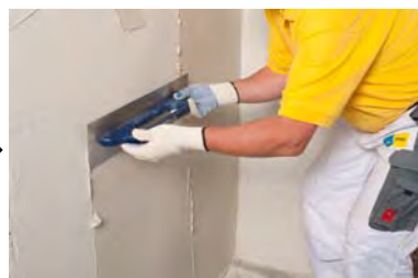
Aufziehen des Oberputzes
