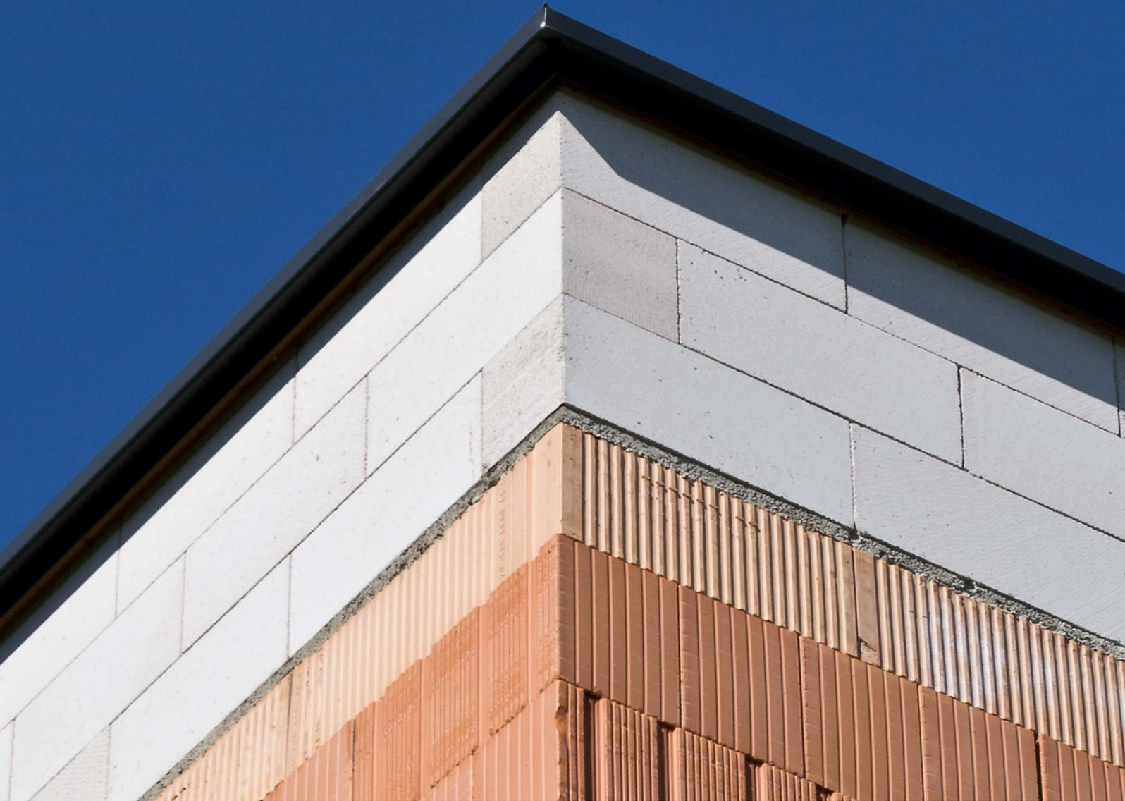
Attikalösungen aus Ytong Porenbeton
