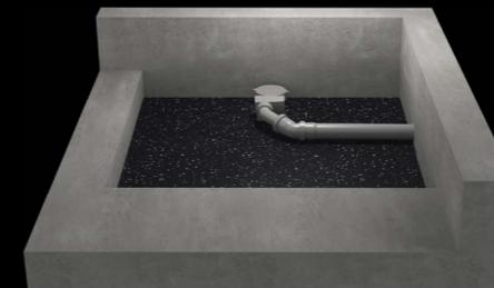
1 Der Ablauf wird wie bei herkömmlichen Duschflächen in der nivellierten Estrichaussparung (Nenngröße der Dusche + 20 mm) positioniert und angeschlossen.
