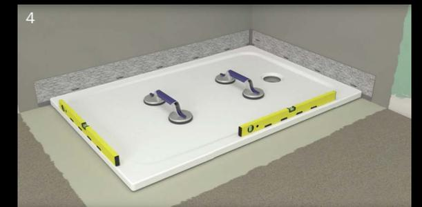
4 • Duschfläche mit Wannenträger umdrehen und auf Boden auflegen, Ablaufgarnitur montieren. Duschfläche abdichten – perfekt mit dem KALDEWEI Dichtset Flex.
