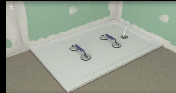
1 • Duschfläche ausrichten und Ablaufposition einzeichnen
