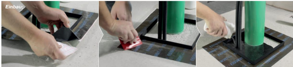
Bauwerksabdichtung gegen aufsteigende Bodenfeuchtigkeit für Durchdringungen, gem. Wassereinwirkungsklasse W-1E DIN 18533
