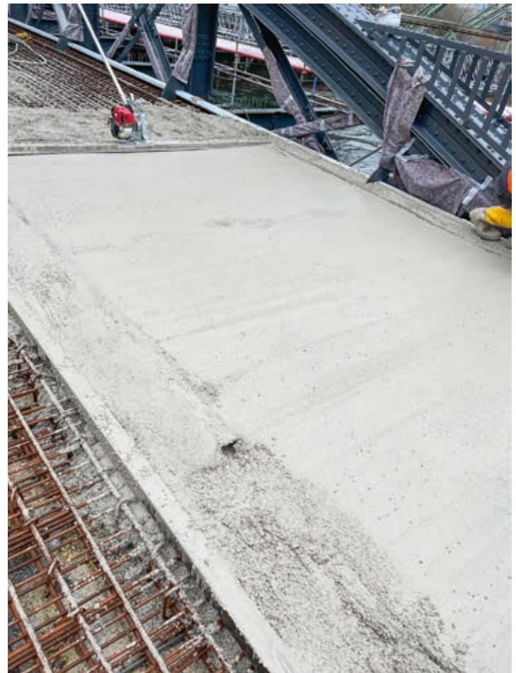
01 Der Einsatz von Liapor-Leichtbeton für Fahrbahn- und Gehwegplatten konnte 100 Tonnen Auflast einsparen.
