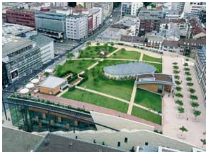
Eine grüne Oase in der Großstadt: Der Dachgarten der Schlössle-Galerie in Pforzheim.
