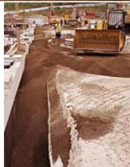
Eine vertikale und eine horizontale Liapor-Schüttung sorgen beim Bau des Bankgebäudes für sichere Stabilität und wirkungsvollen Schallschutz.
