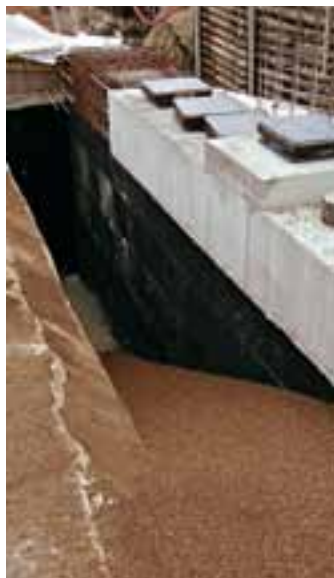
Die Hohlräume neben dem U-Bahntunnel wurden bis zu neun Meter hoch mit Liapor verfüllt.
