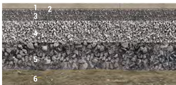
Abbildung 4: Aufbau gebundene Bauweise (Oberbau 1–5)
