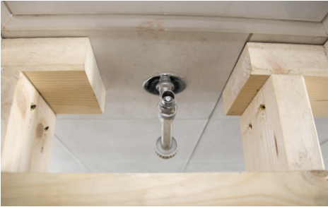
✓ Wasseranschluss mit Anschlagschutz
