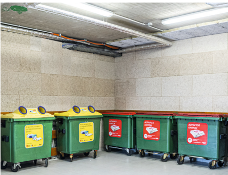
✓ gut ausgeleuchtet ✓ Anschlagschutz ✓ ausreichend Platz nach oben, um den Behälter zu öffnen
