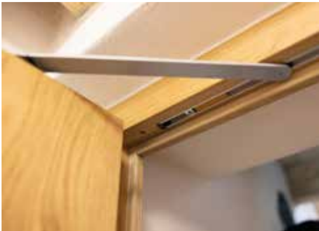
Integrierter Türschließer
