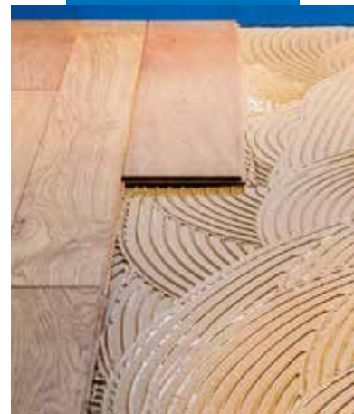
Verlegung von Parkett
