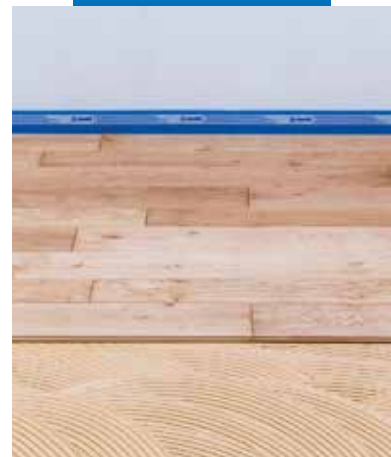
Verlegung von Parkett
