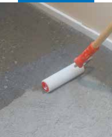
Auftragen von Primer G mit der Rolle
