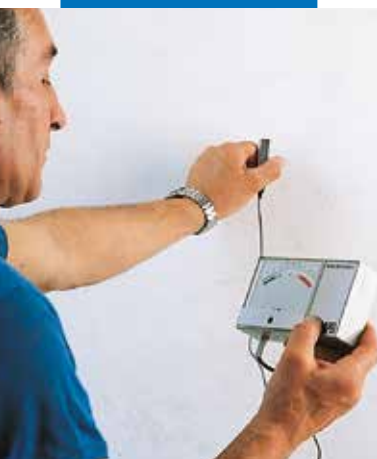
Feuchtemessung des Putzuntergrundes
