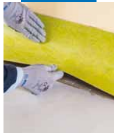
Verlegung eines Hohlkehl-Sockels und Belag mit Ultrabond Eco Fast Track
