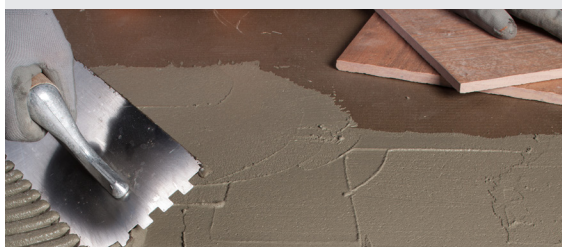
Fliesen kleben mit Elastorapid
