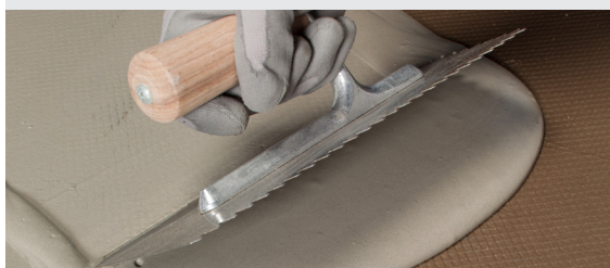
Auftragen der zweiten Schicht Mapelastic Turbo
