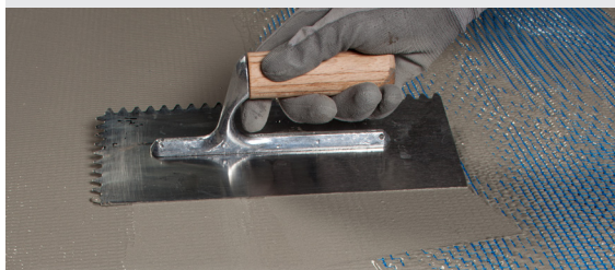
Einbetten von Mapenet 150 in die erste Schicht Mapelastic Turbo
