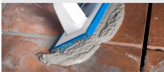
Verfugen der Fliesen mit Ultracolor Plus
