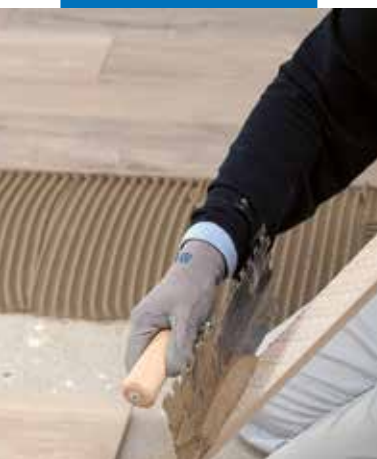
Aufziehen des Klebemörtels im Buttering-Floating-Verfahren
