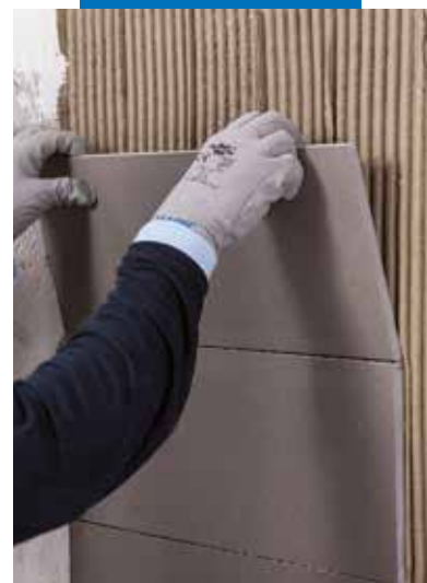
Verlegung von Keramik im Wandbereich
