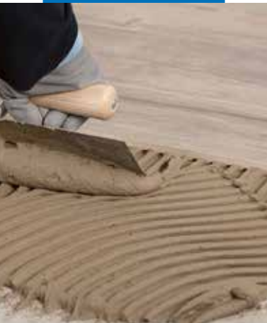
Verlegung von Feinsteinzeugfliesen mit Holzoptik
