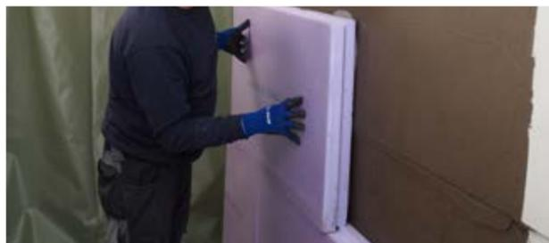
Verklebung einer Dämmplatte mit Mapelastic 2KR
