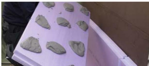
Verklebung einer Dämmplatte mit Mapelastic 2KR
