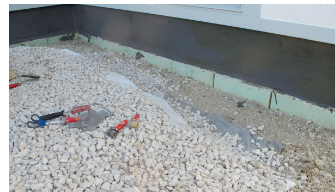
Abgedichteter Haussockel (bereits durchgetrocknet)
