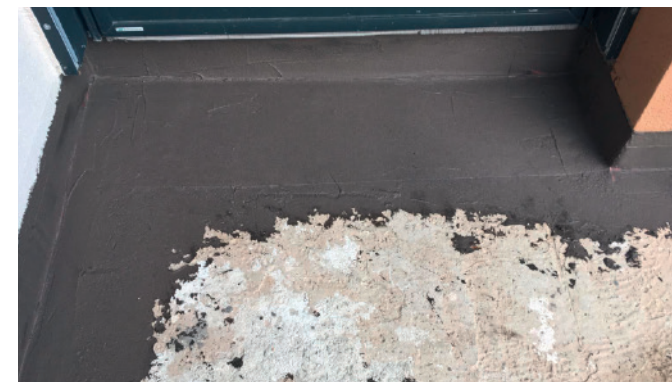
...und mit Sopro ZR Turbo MAXX überarbeiten
