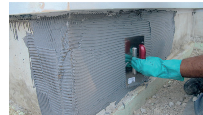
Sopro ZR Turbo MAXX aufgezahlt und danach geglättet...
