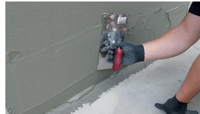
Leichtes Aufbringen von Sopro ZR Turbo MAXX
