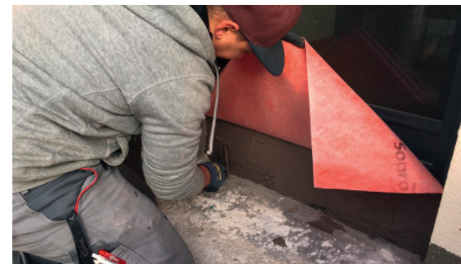
Sopro ZR Turbo MAXX auf den Untergrund aufbringen
