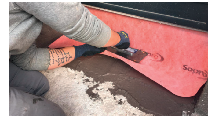
Sopro PortalDichtBand sorgfältig andrücken...
