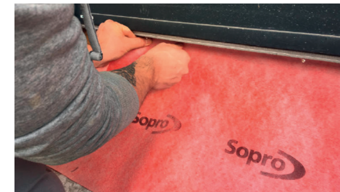
Sopro PortalDichtBand mit Selbstklebestreifen fixieren
