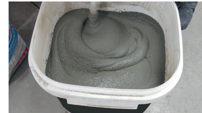
Vorbereiten der beiden Komponenten und Anmischen zu einer homogenen Masse...
