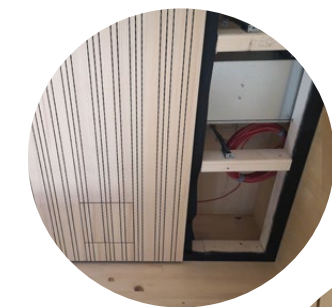
UK aus abgehängten Holzstaffeln und umlaufender Leiste für Schattenfuge
