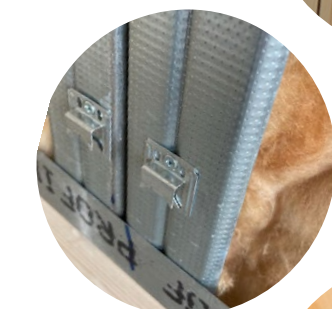
Montage an Trockenbauschiene mittels Montagekralle
