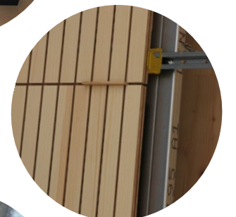
Montage an Trockenbauschiene mit Hutprofil und Drehclip
