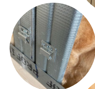
Montage an Trockenbauschiene mittels Montagekralle
